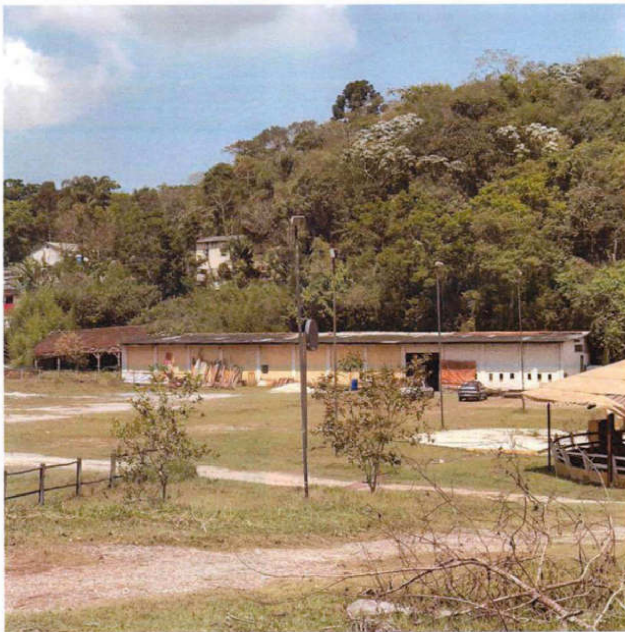
GALPÃO DE MANUTENÇÃO – FERRAMENTAS E EQUIPAMENTOS
