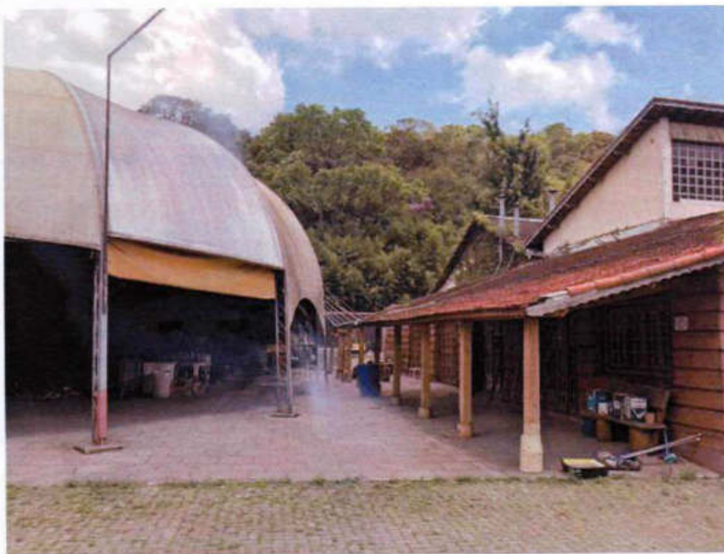
GALPÃO DE EVENTOS / TOLDO / FUNDO DO BAR
