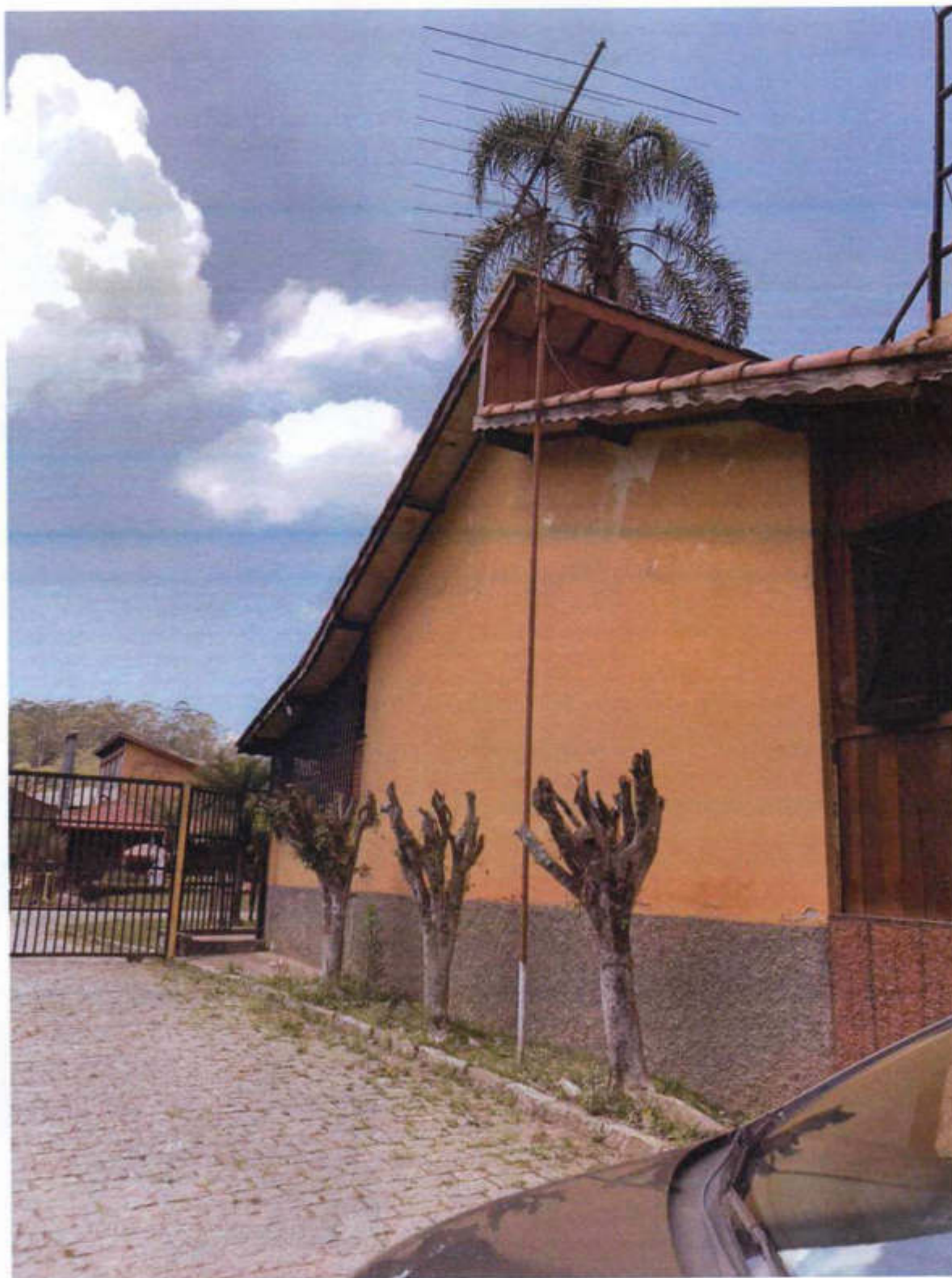
LATERAL DO ESCRITÓRIO – ACESSO PRINCIPAL
