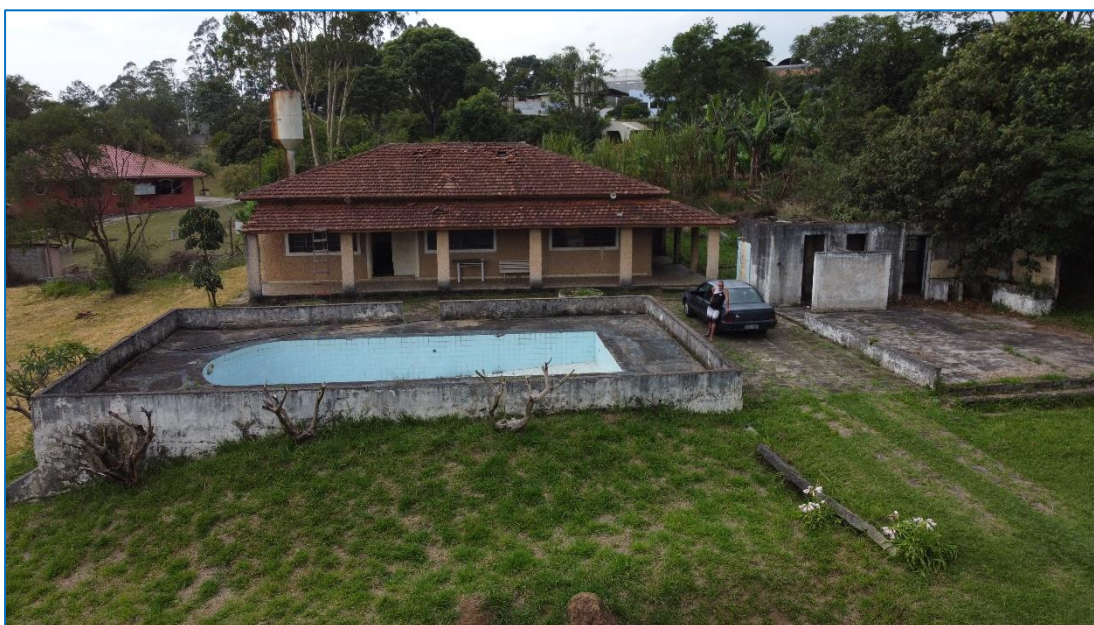
Aspectos gerais do imóvel.
