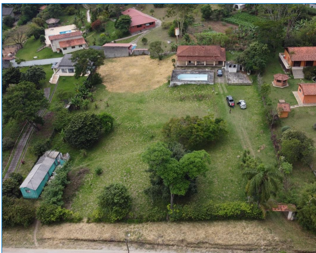
Vista do imóvel.
