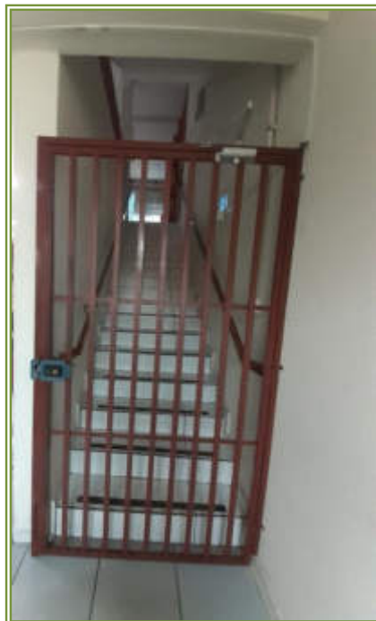
Escada de acesso 2º andar
