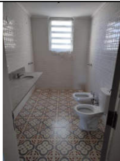
Foto 38 – Banheiro da suíte.
