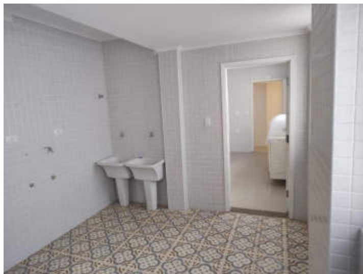
Foto 18 – Área de serviço, instalações para máquina e dois tanques.
