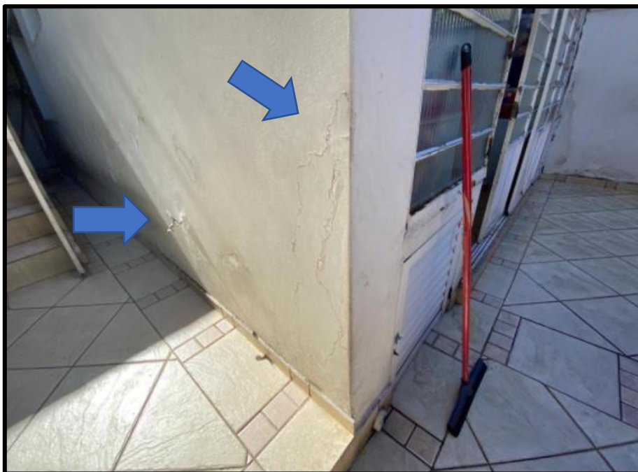
Foto 16: Infiltração aparente
