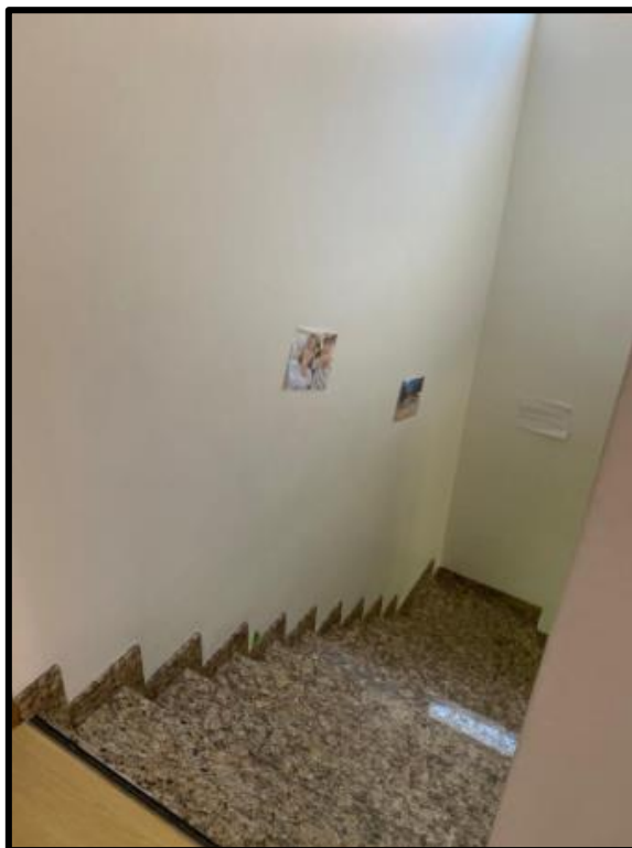
Foto 7: Circulação vertical - acesso 1º pav.
