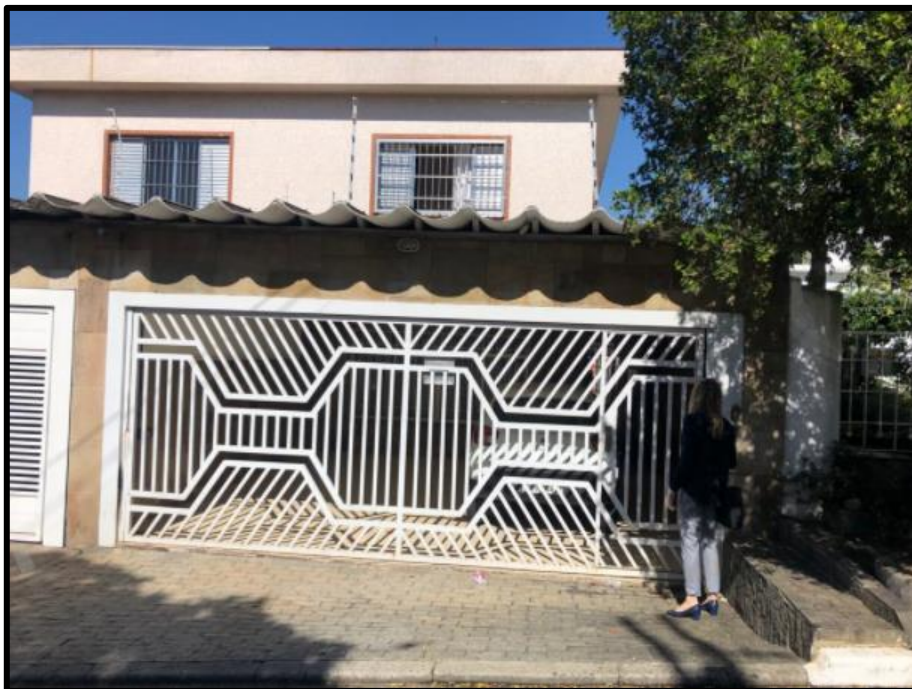
Foto 1: Fachada do imóvel – Rua Soldado José Alves de Abreu, nº270
