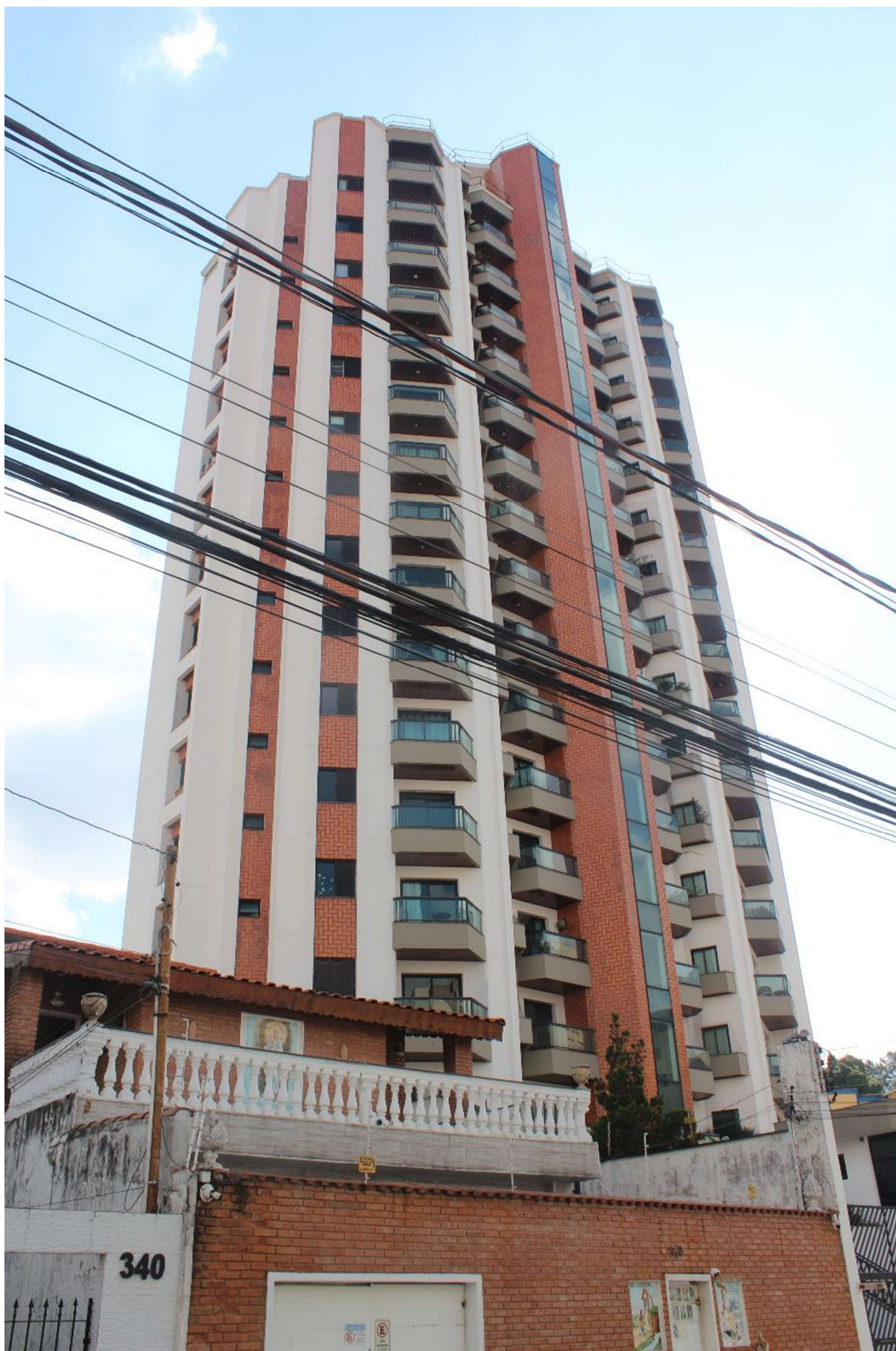
Legenda: Fachada Externa do Edifício Los Angeles.
