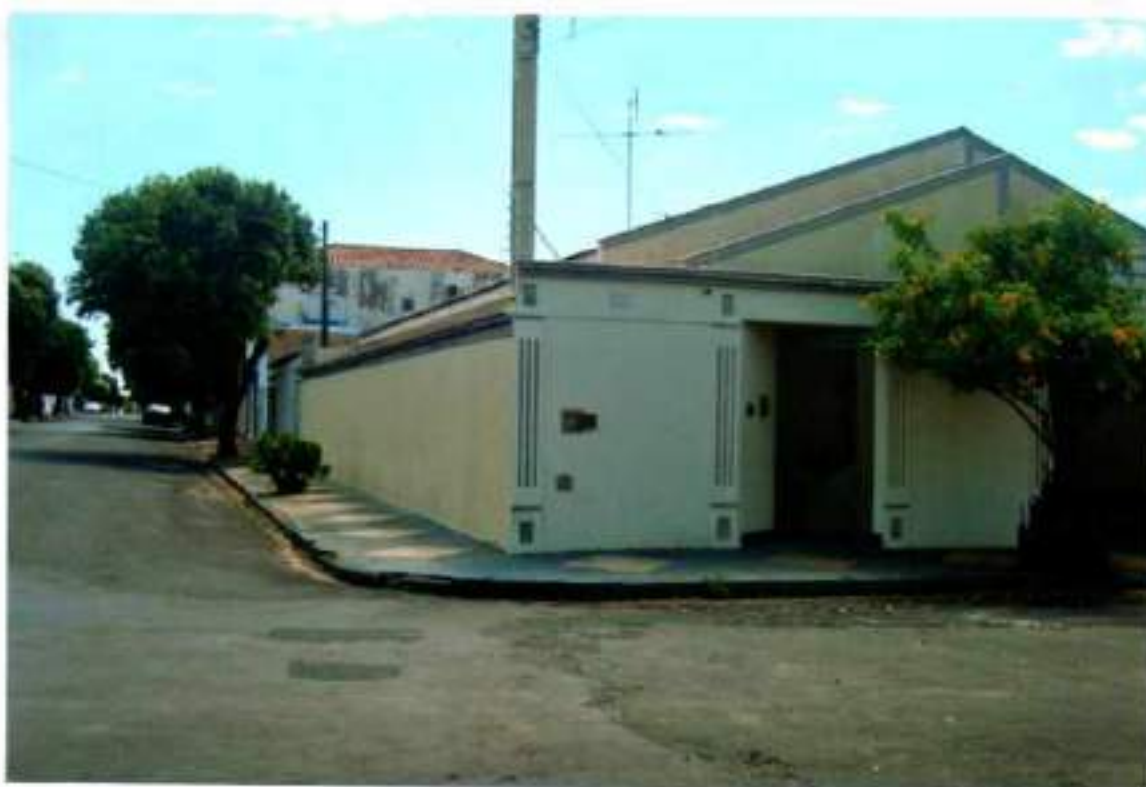
Vista da parte da frente da construção, com um só pavimento, do tipo residencial unifamiliar, localizada de esquina, descrita detalhadamente no corpo do laudo.
