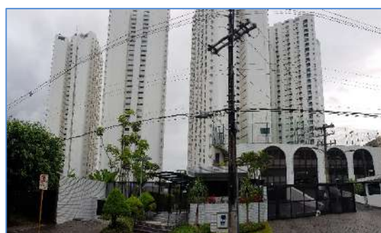
Foto 18 – Vista das fachadas do Condomínio Tortuga's
