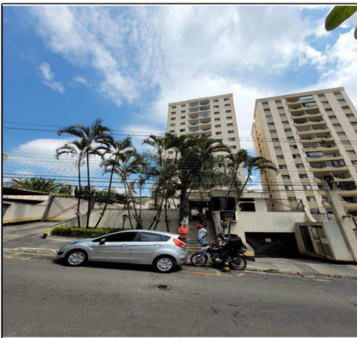
Foto 1: Vista do imóvel avaliando.
