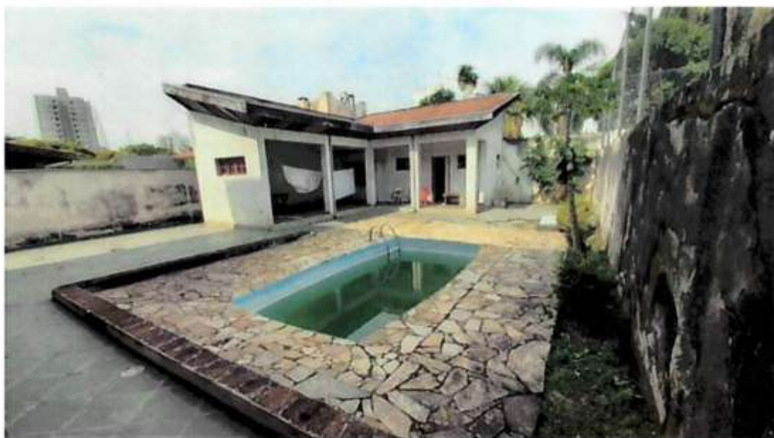
Foto 32. Vista da piscina com construção adjacente
