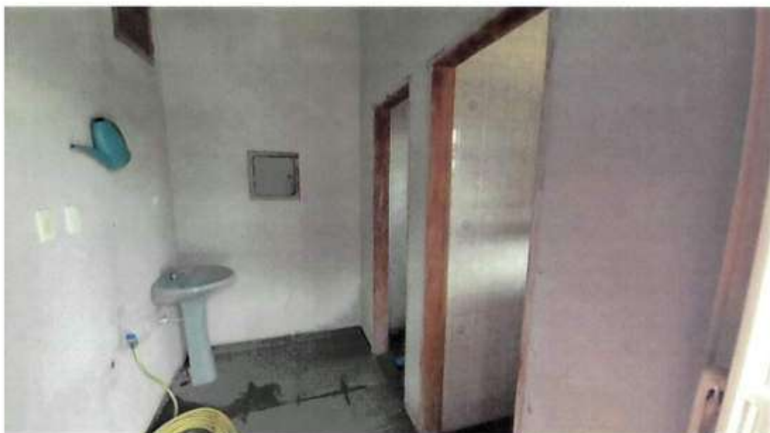
Foto 33. Vista dos banheiros externos da construção adjacente
