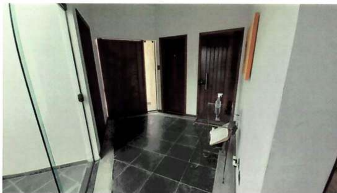
Foto 05. Vista do hall de entrada do imóvel
