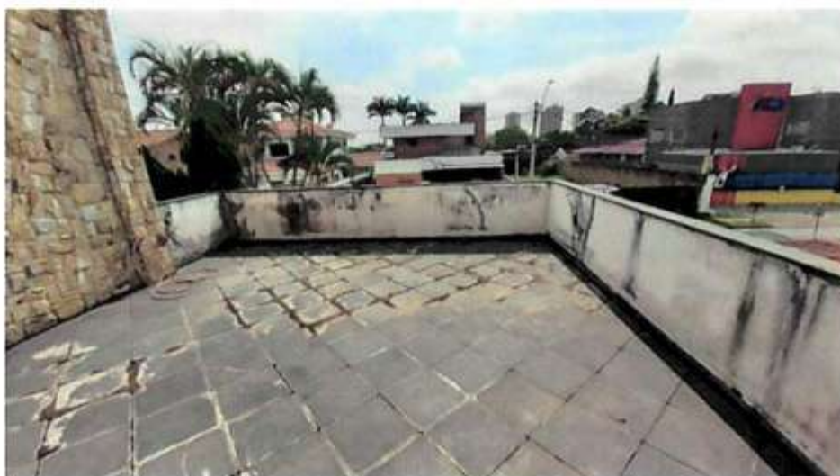
Foto 28. Terraço superior com vista para a Rua Bolívia
