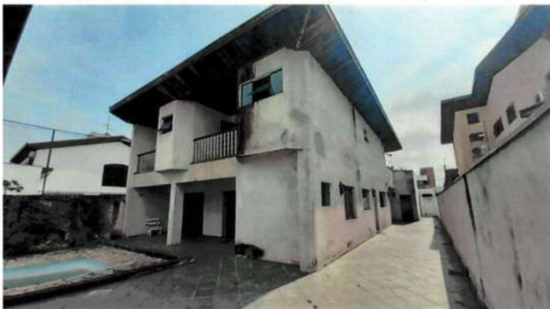
Foto 36. Vista posterior do imóvel e seu recuo lateral
