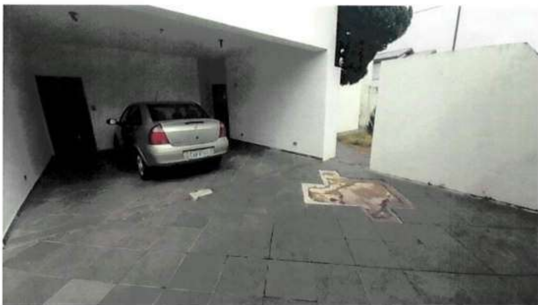
Foto 04. Vista da garagem do imóvel
