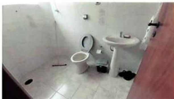
Foto 14. Banheiro de empregada.
