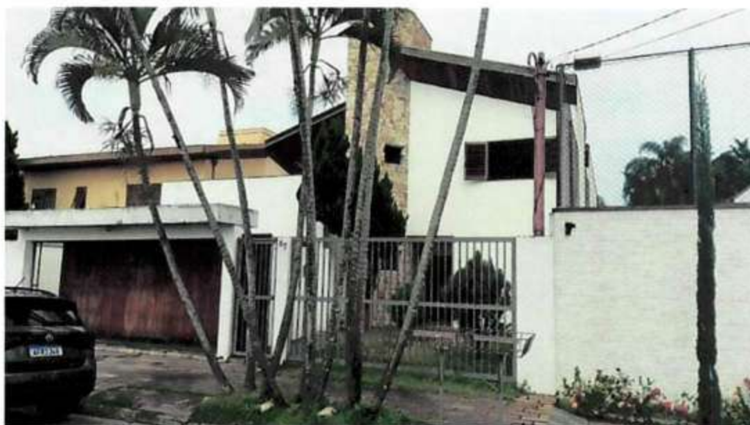
Foto 02. Vista frontal do imóvel avaliando
