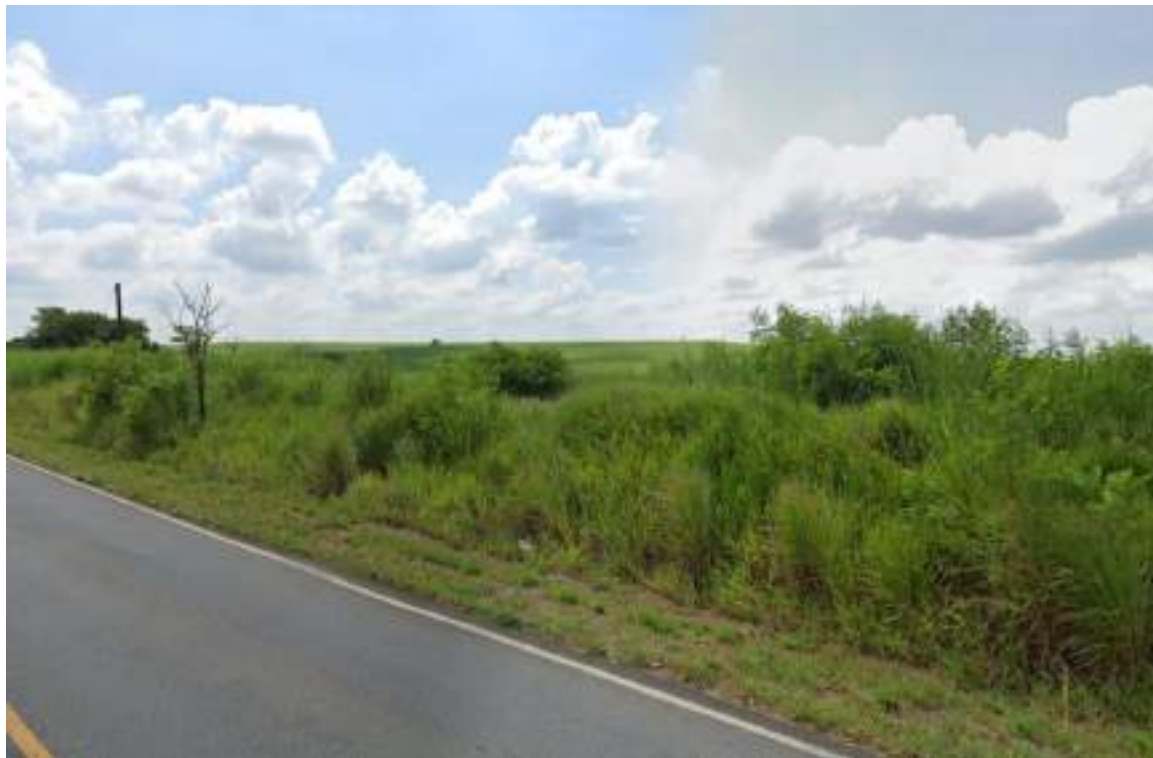
Elem. 5 Rodovia BTV 40, s/nº 23°14'51.3"S 47°41'16.5"W
