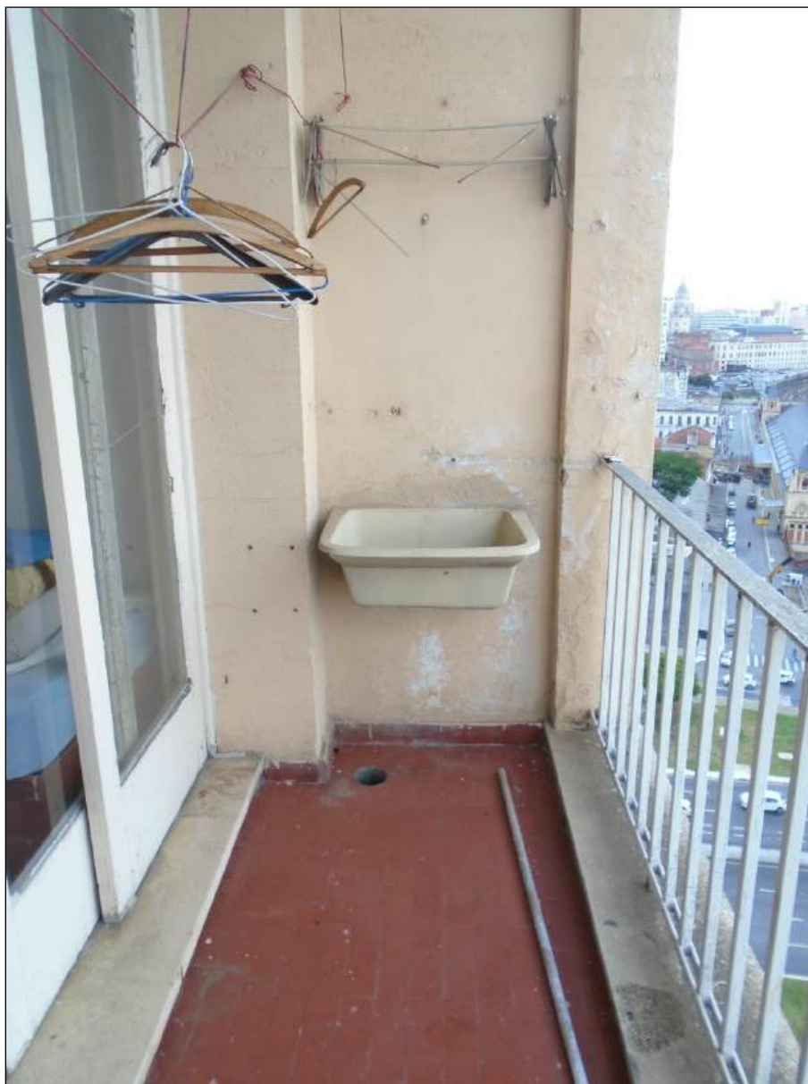
FOTO 24 – ASPECTO DAS CARACTERÍSTICAS DA VARANDA.
