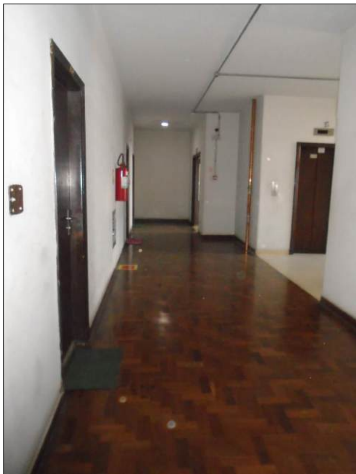
FOTO 11 – ASPECTO GERAL DO HALL DO PAVIMENTO DO 15º ANDAR
