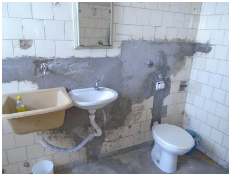
FOTO 23 – INTERVENÇÕES REALIZADAS PARA ELIMINAR VAZAMENTOS.
