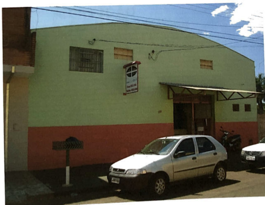
FOTO 02 – Vista da outra frente do imóvel em questão. Rua José Bonifácio nº 230.
