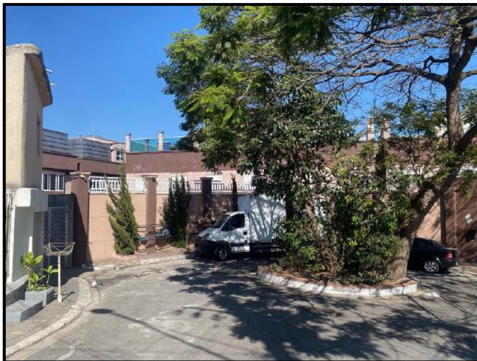
Foto 1: Fachada do condomínio
