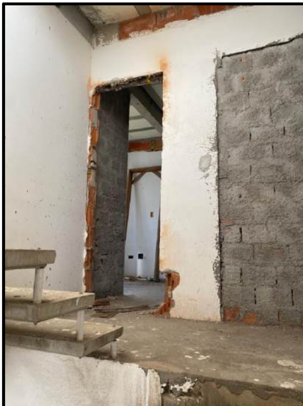
Foto 11: Acesso piso superior
