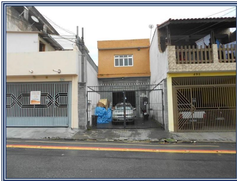
Vista da frente do imóvel avaliando.
