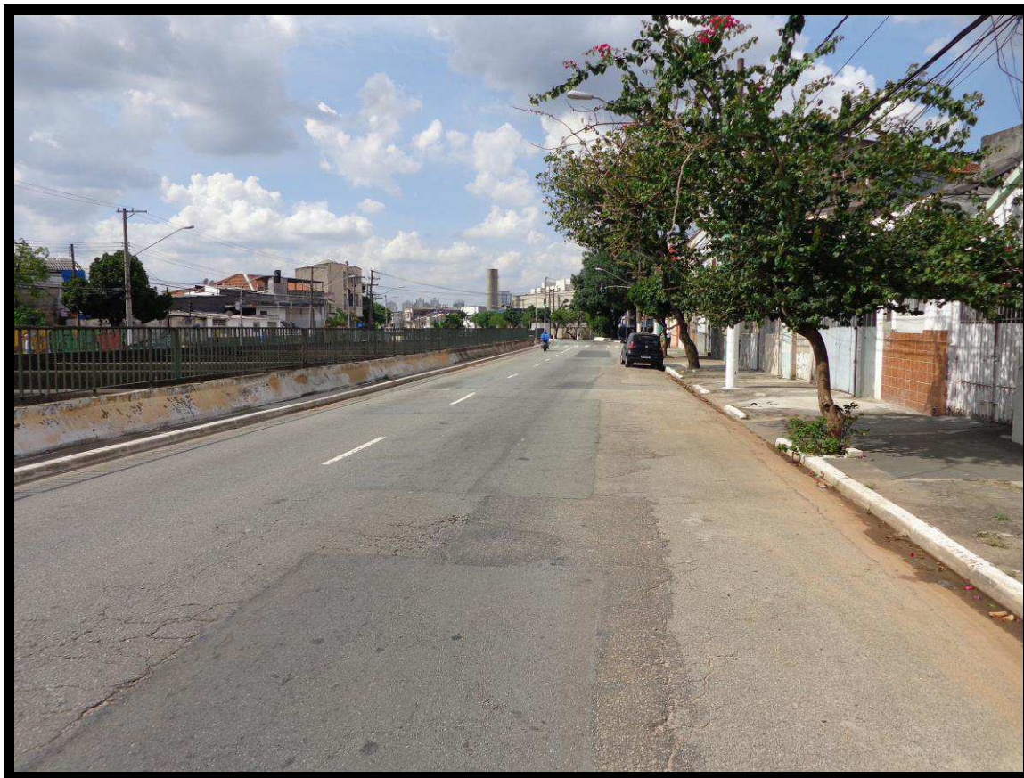
Vista da Avenida Teresa Cristina.
