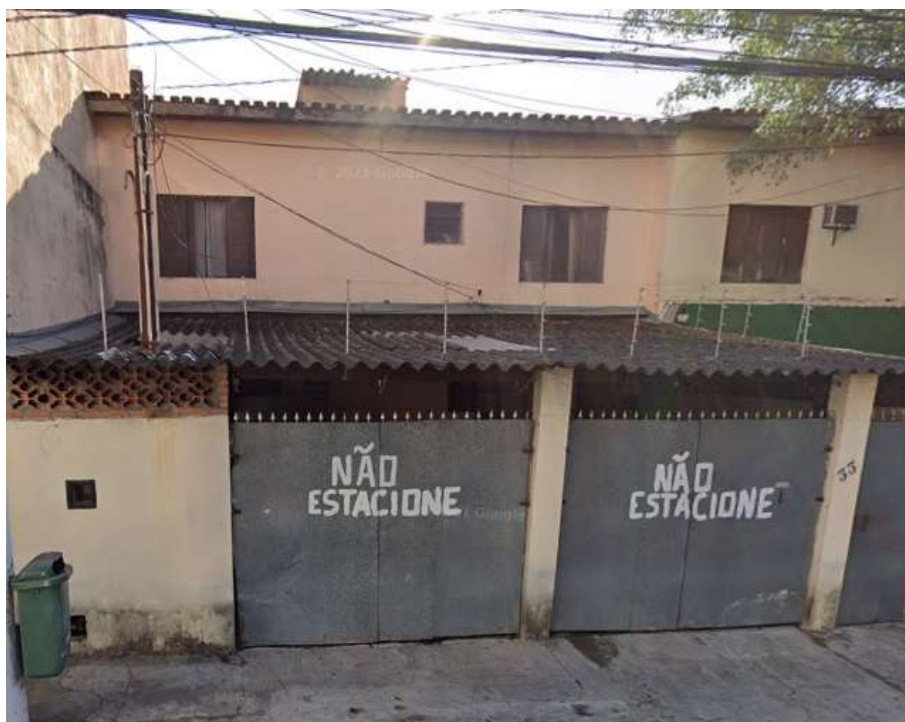
ASPECTOS GERAIS DA CASA Rua: Manoel Soares Sebastião nº 33
