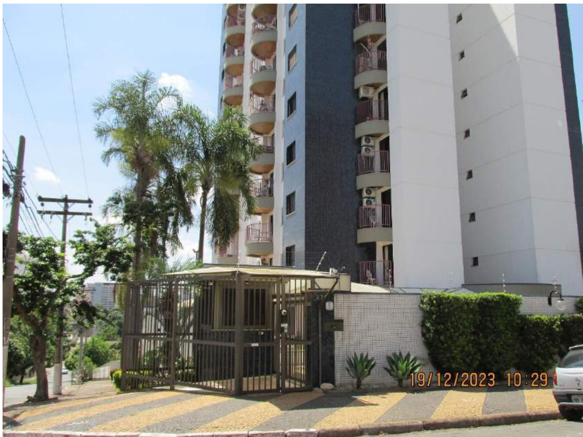
Fachada da Portaria
