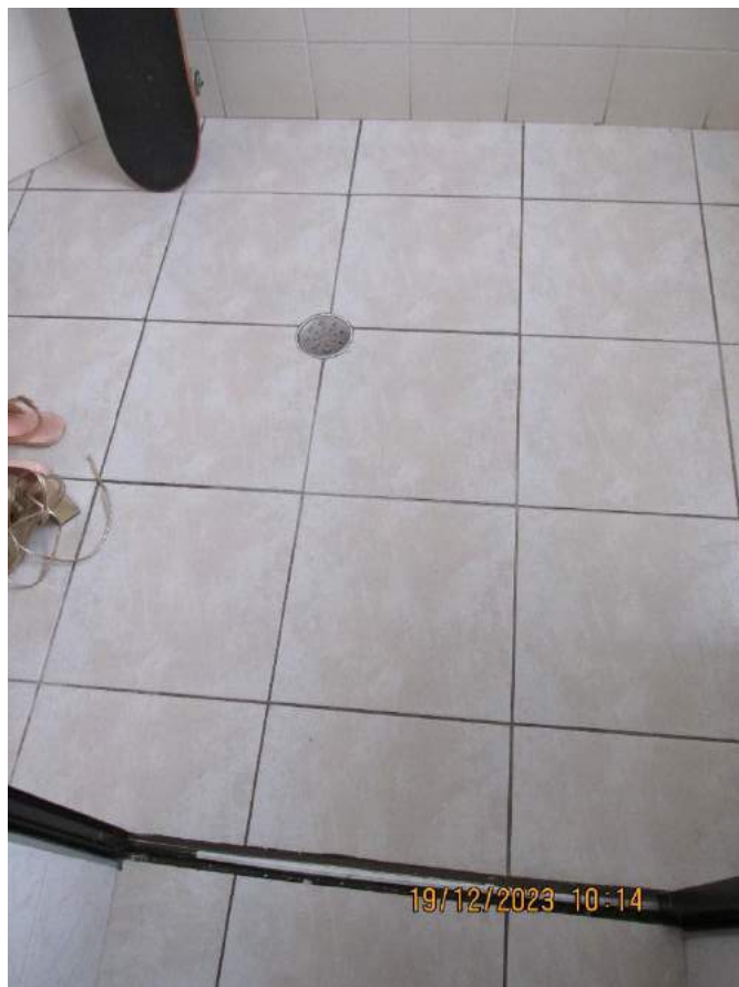
Piso/Área de Serviço
