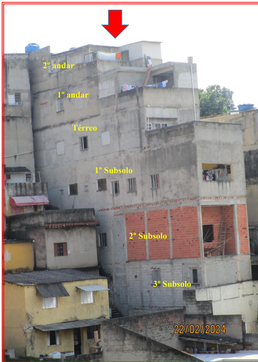
Foto nº 03: Vista panorâmica das fachadas lateral e posterior (fundos) do imóvel avaliando.
