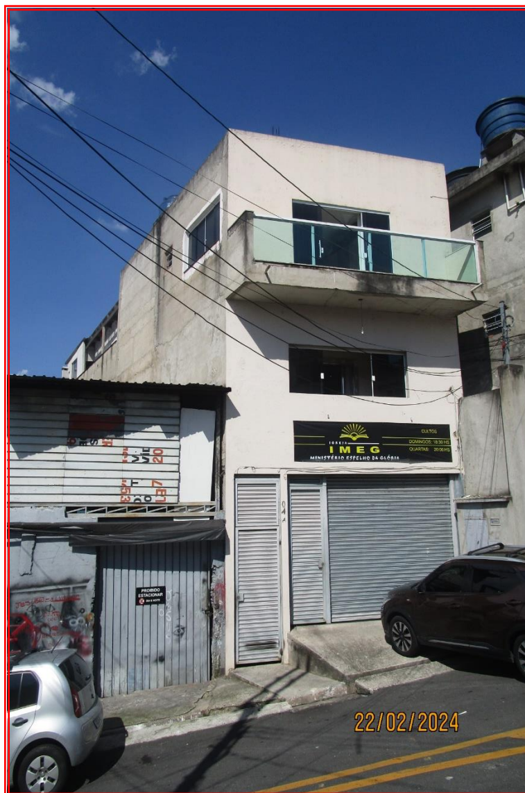
Foto nº 04: Vista geral da fachada frontal do imóvel.
