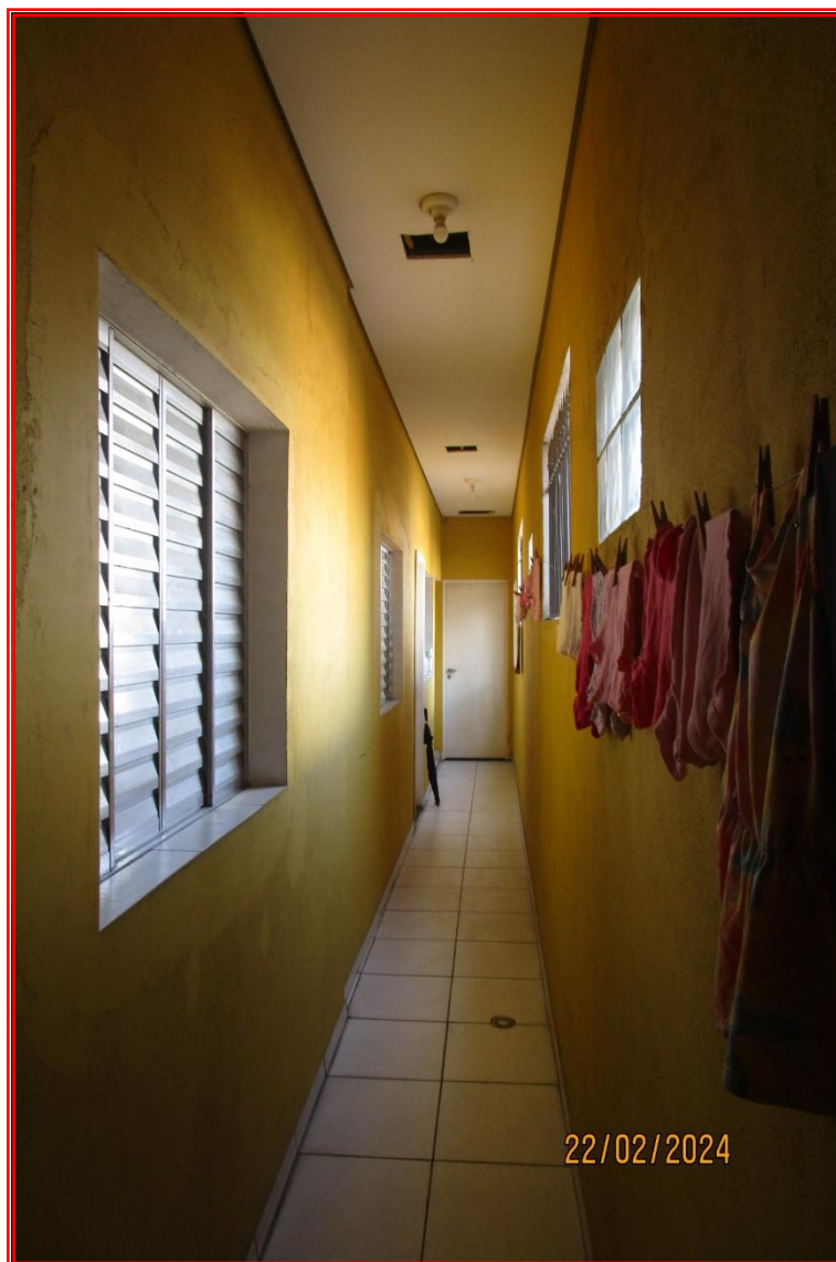
Foto n° 08: Vista parcial do corredor do 1º subsolo, com detalhe para a residência à esquerda (alugada).
