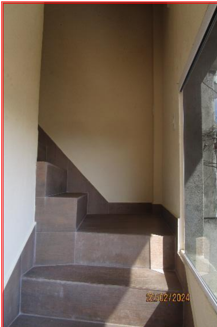
Foto n° 38: Vista parcial da escada de acesso ao pavimento superior do 2º andar.
