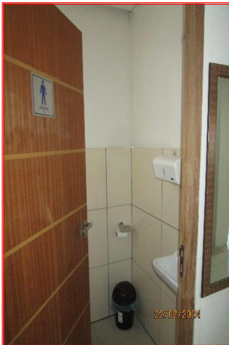
Foto nº 22: Vista parcial do banheiro.
