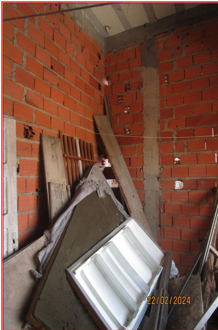
Foto n° 14: Vista da residência inacabada, tomada em outro ambiente.
