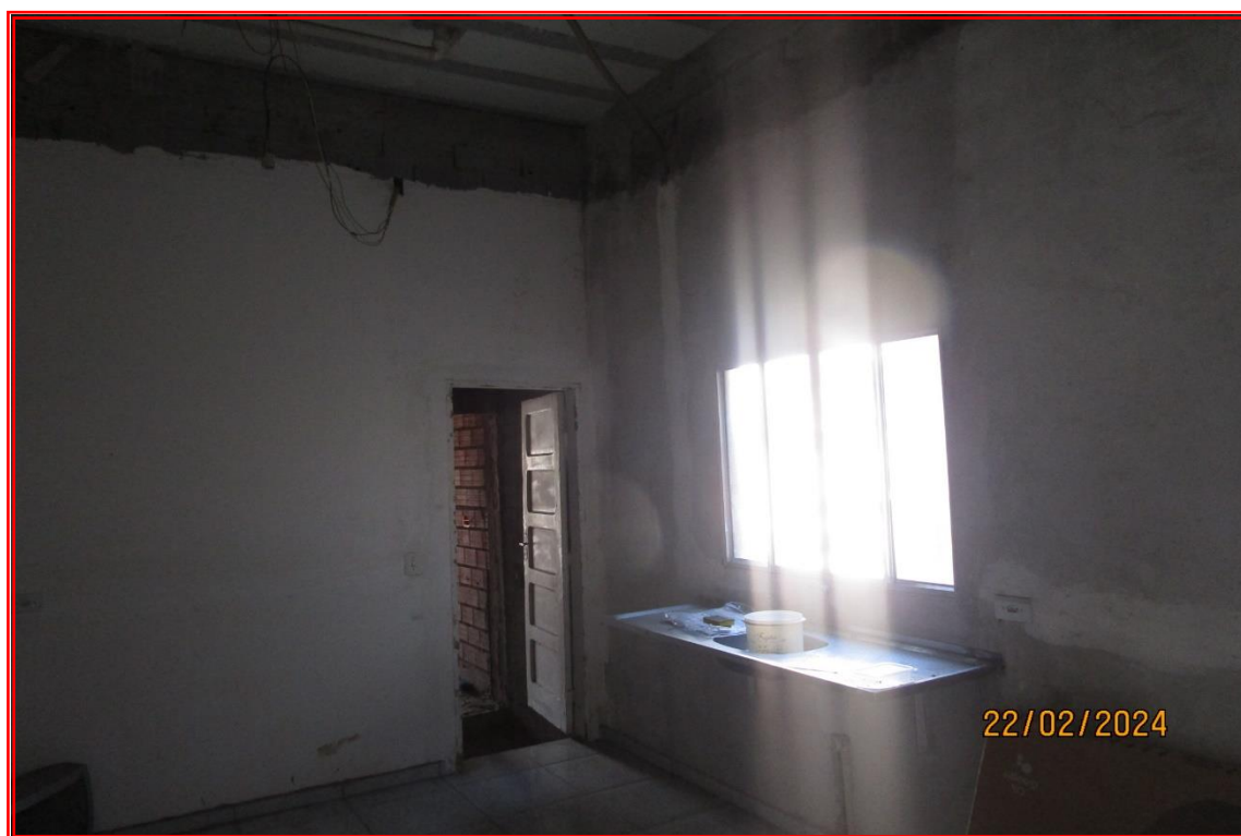
Foto nº 16: Vista parcial da cozinha.
