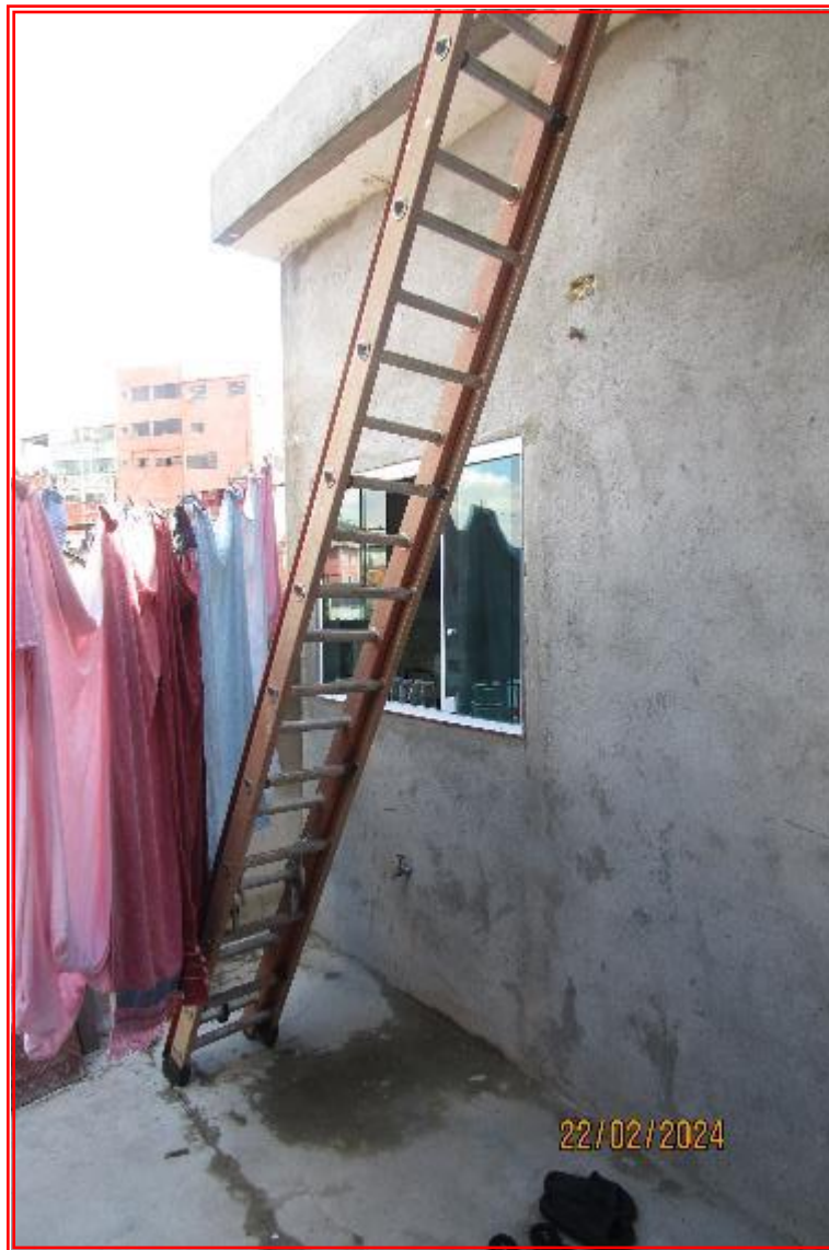
Foto nº 37: Vista parcial da área externa descoberta.
