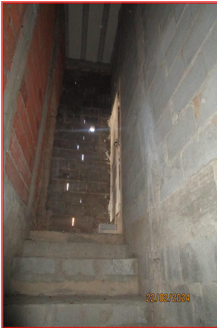
Foto n° 12: Vista da escada de acesso a residência (inacabada) localizada no 2º subsolo (desocupada).
