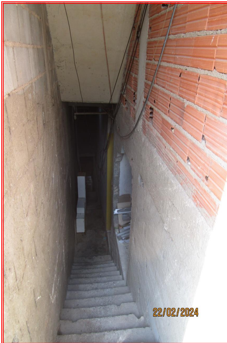
Foto nº 07: Vista da escada de acesso aos pavimentos subsolos.
