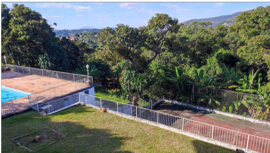
Construção existentes em partes dos Lotes 14 e 15
