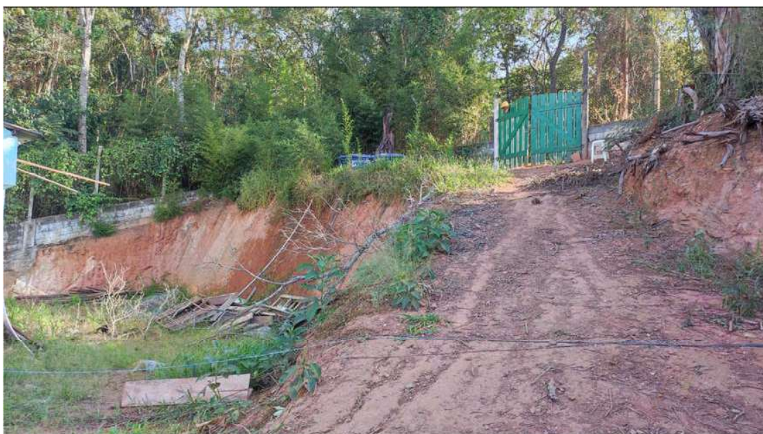
Vista interna de acesso ao imóvel através do portão situado em frente ao Lote 14.
