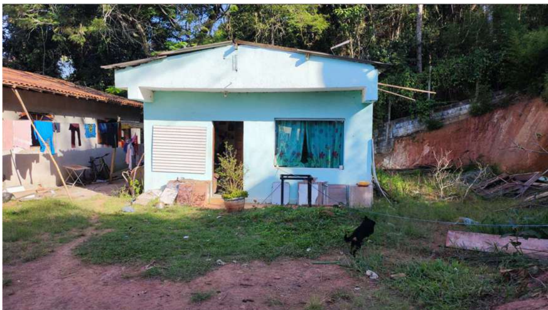
Construção existente no Lote 14.
