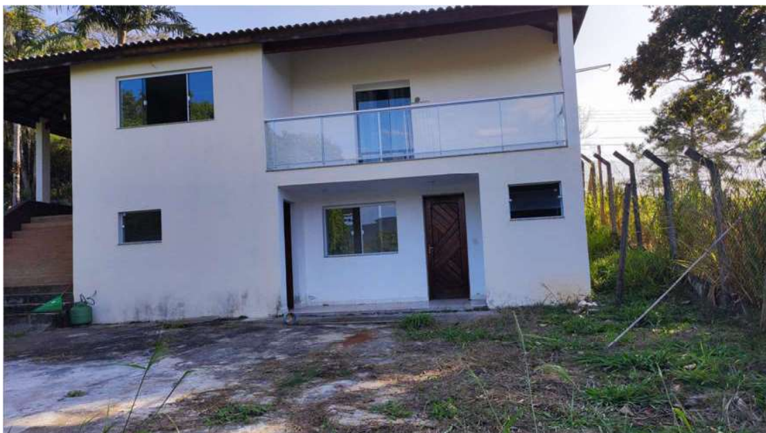
Vista dos fundos da construção existente no lote 17 – ao lado a cerca de divisa.
