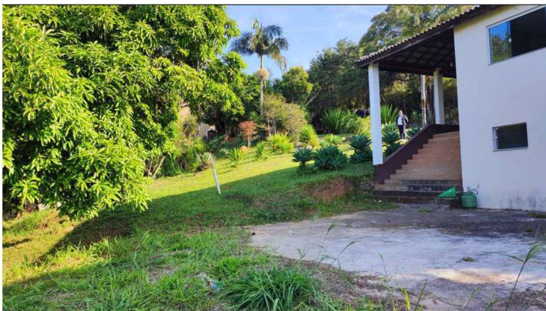
Vista da lateral da construção existente no lote 17.
