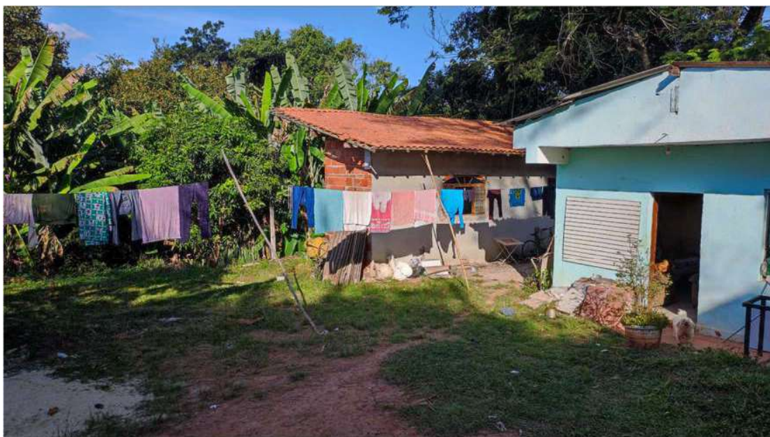
Construção existente no lote 14
