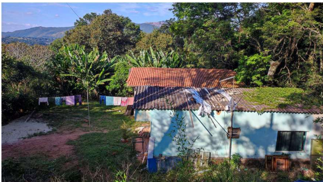
Construção existente no Lote 14
