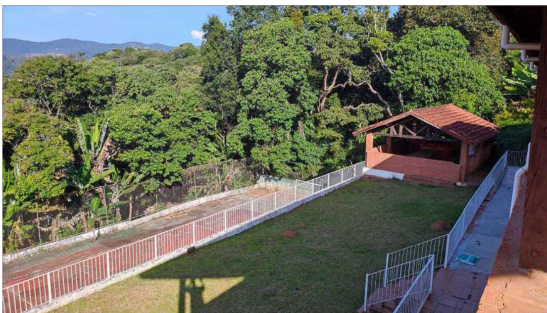
Construção existente em partes dos Lotes 14-15
