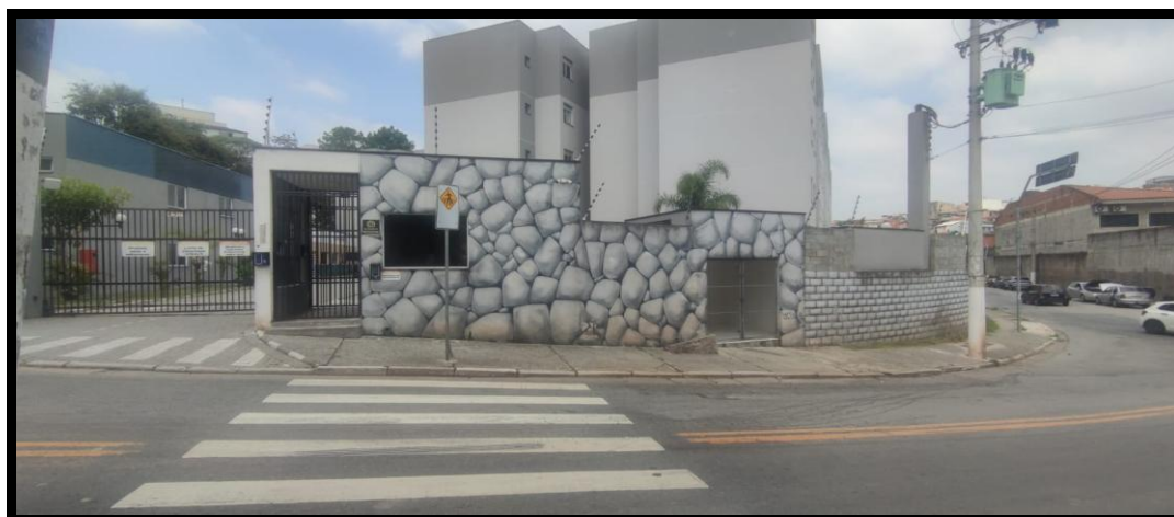
Outra vista da entrada do Condomínio Residencial Recanto das Rosas.
