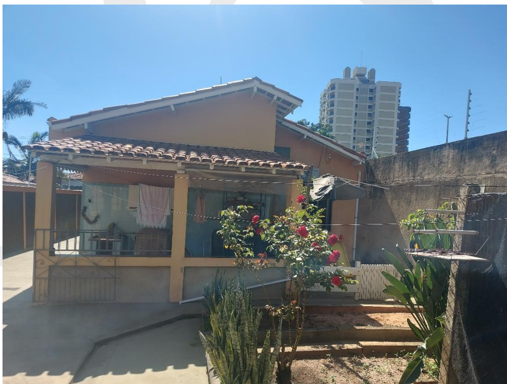
Fotografia 22: Visão da fachada posterior.
