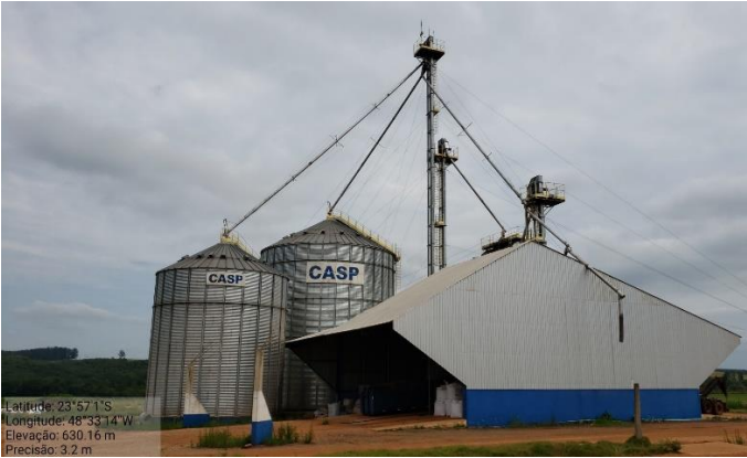
Foto 03 – Silo imóvel IA
