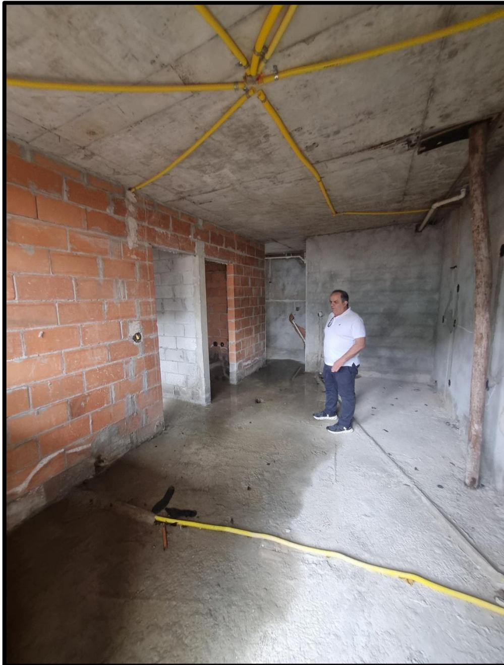
**Foto nº 17** – Vista da sala de estar de cozinha de outra unidade futura. Observa-se a diferença de material utilizado no fechamento das paredes de alvenaria.
