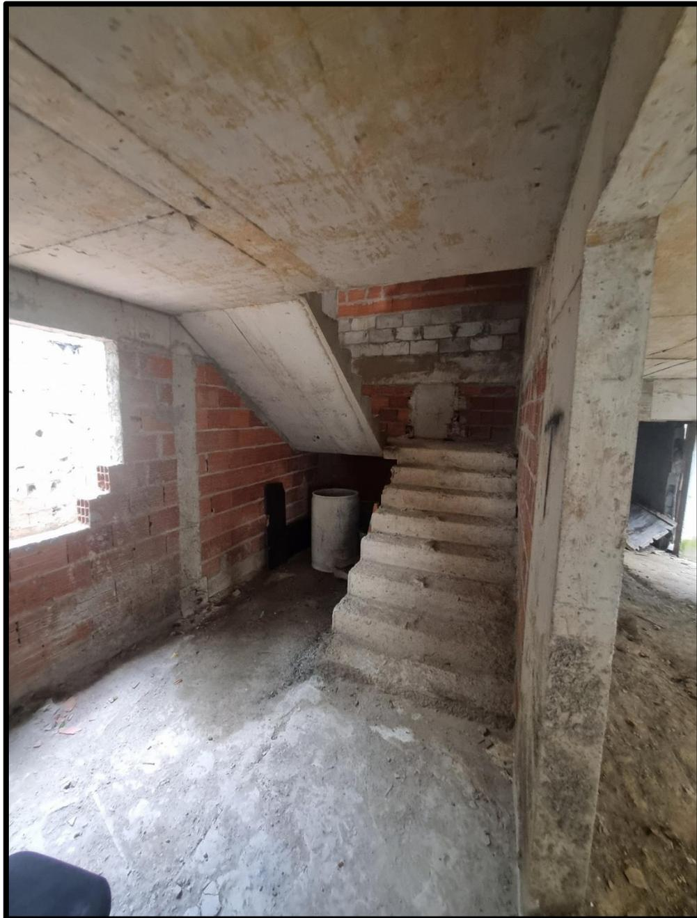
**Foto nº 07** – Ilustra a caixa de escadaria de emergência.
