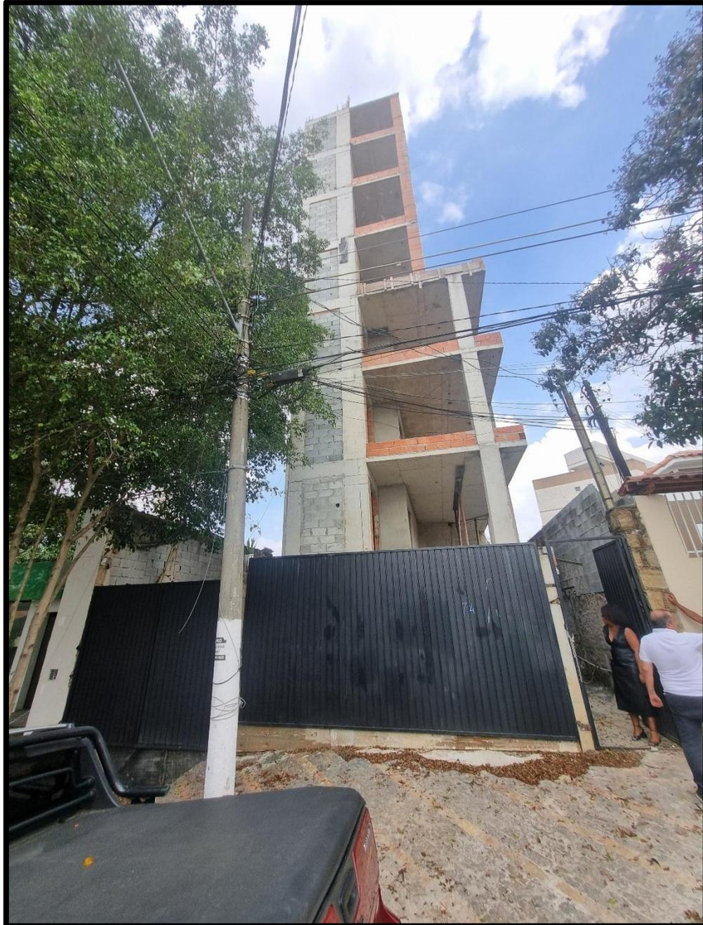
**Foto nº 03** – Vista da fachada frontal do edifício. Observa-se que somente 07 (sete) dos 10 (dez) pavimentos que compõem o edifício estão construídos.
