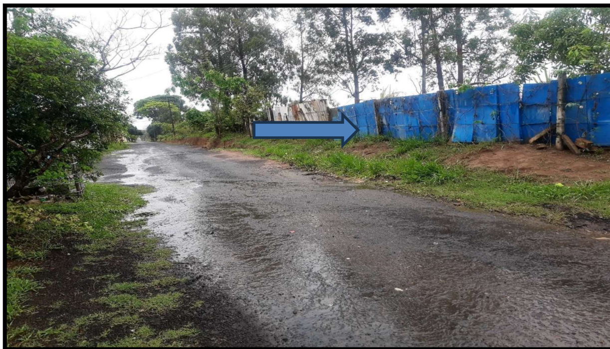
Foto 6 - Vista frontal do imóvel pela Rua 5Pe, onde ilustramos as características da via pública, sem passeio público, guias e sarjetas, com piso em asfalto rústico.
