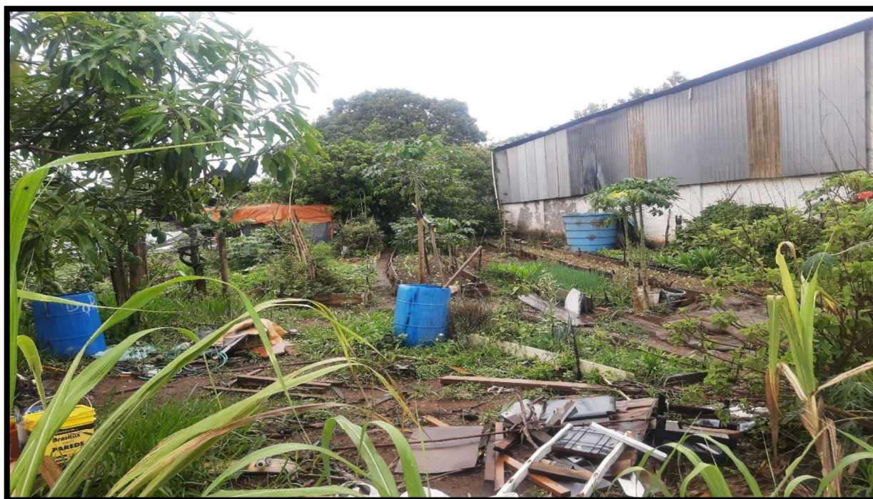
Foto 4 - Vista do interior do imóvel em avaliação, onde ilustramos sua utilização, e o barracão com suas características construtivas.
