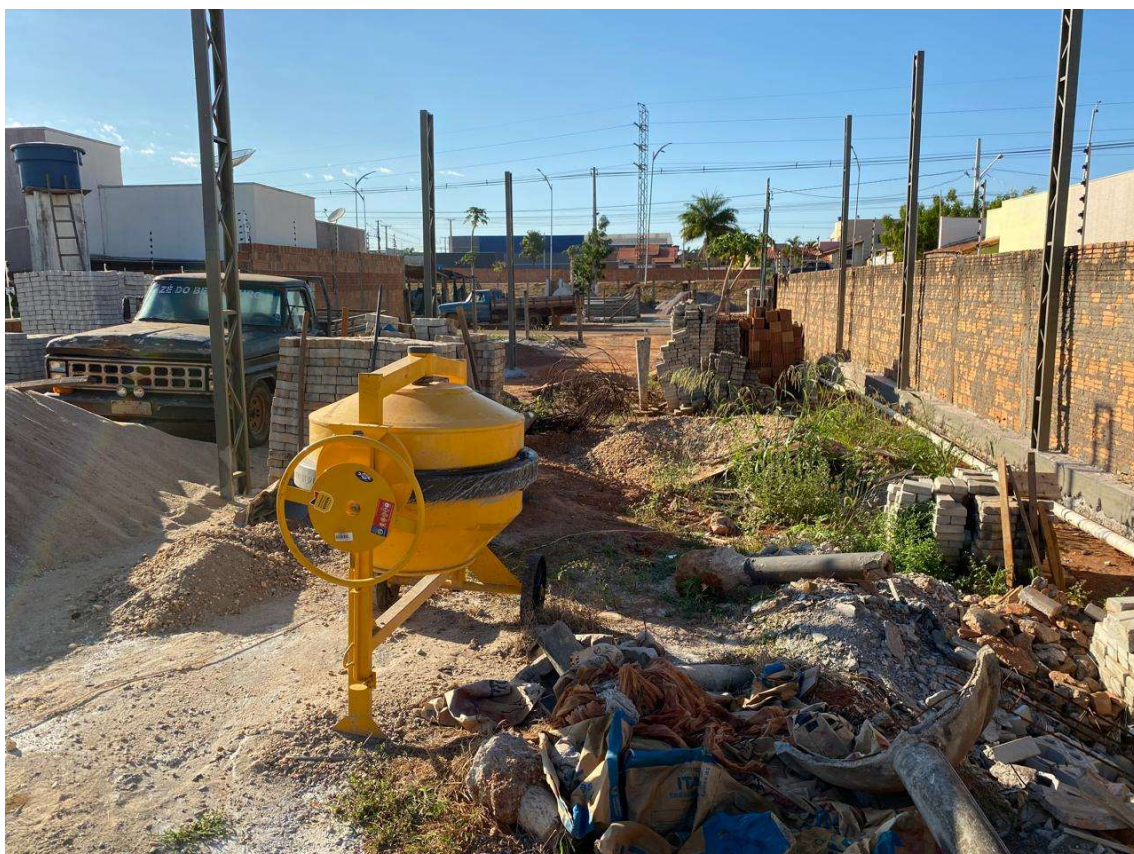
Aspectos das fundações do barracão
