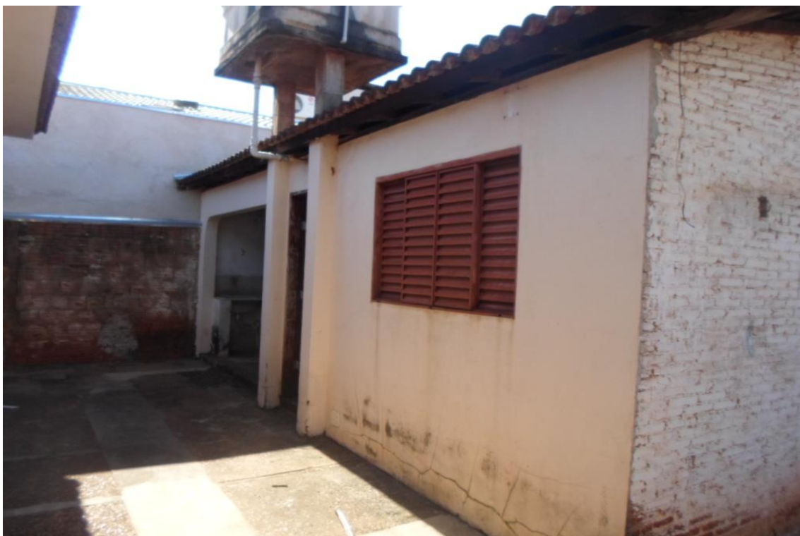
FOTOS 8, 9 E 10 – Anexo fotográfico destinado a mostrar algumas das paredes externas da edificação onde foram observados problemas na argamassa de revestimento (reboco soltando/desagregando).
