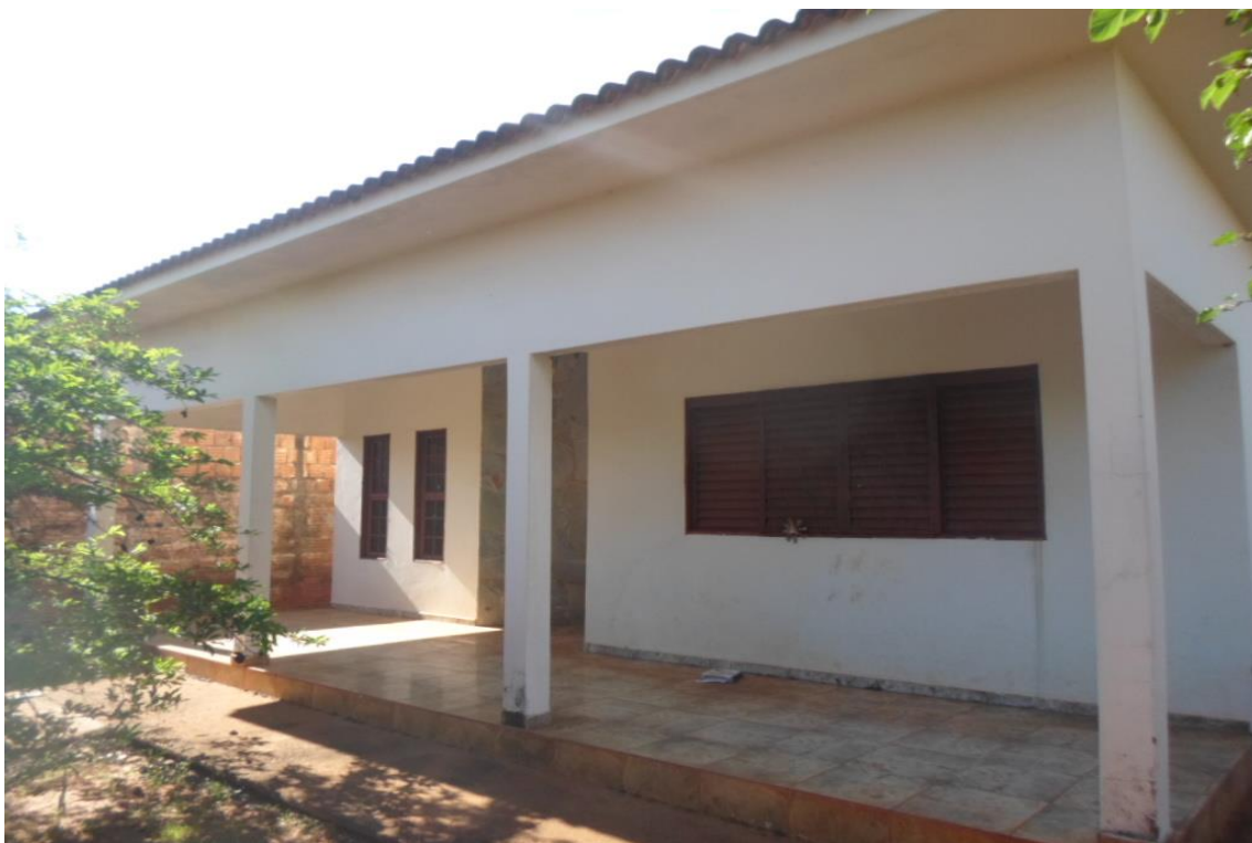
FOTO 4 – Anexo fotográfico destinado a mostrar a frente da edificação objeto desta perícia, com frente para a Rua Jose Desidério Fernandes n.º 480.
