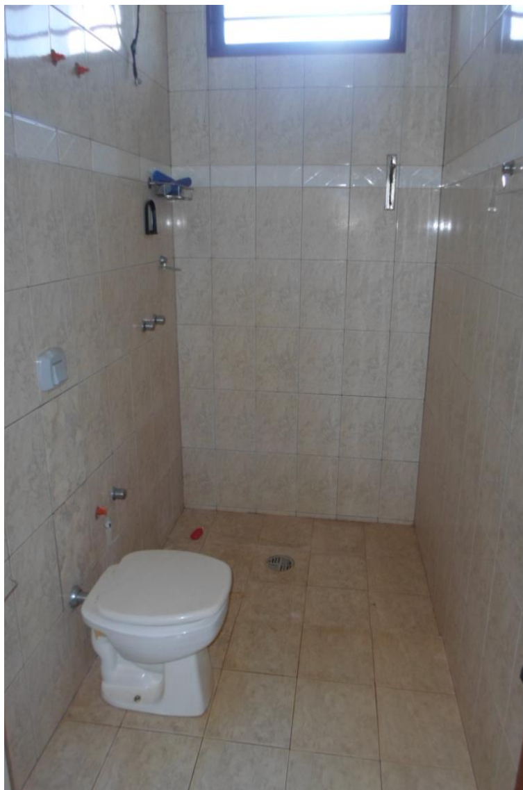
FOTO 23 – Anexo fotográfico destinado a mostrar outro banheiro existente na referida edificação, podendo-se observar o piso e o revestimento cerâmico.
