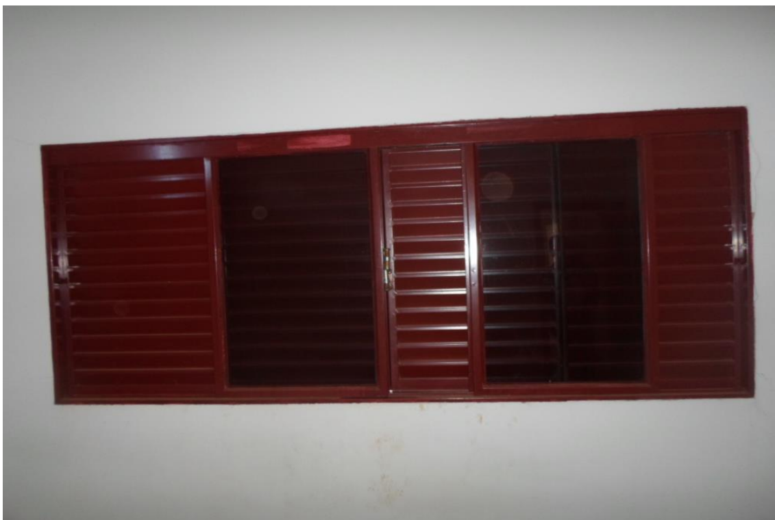
FOTO 26 – Anexo fotográfico destinado a mostrar a esquadria metálica existente em um dos dormitórios da referida edificação.
