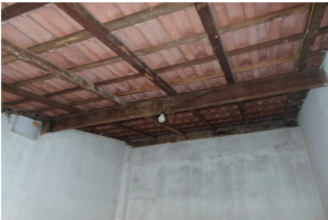
FOTOS 11, 12 E 13 – Anexo fotográfico destinado a mostrar a edícula existente na referida edificação podendo-se observar o piso tipo cimentado, a cobertura com telhas cerâmicas sem qualquer tipo de forro e a pintura das paredes em péssimo estado de conservação.
