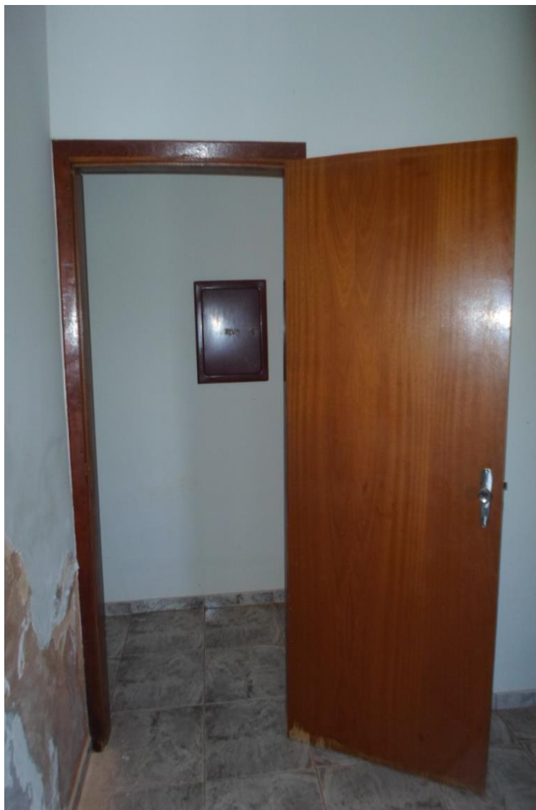
FOTO 22 – Anexo fotográfico destinado a mostrar uma das portas internas da edificação, podendo-se observar o seu regular estado de conservação.
