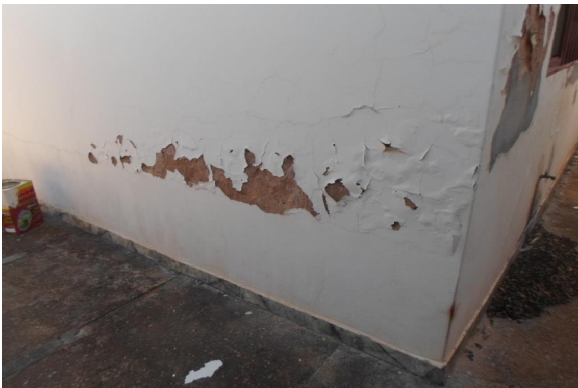
FOTOS 8, 9 E 10 – Anexo fotográfico destinado a mostrar algumas das paredes externas da edificação onde foram observados problemas na argamassa de revestimento (reboco soltando/desagregando).
