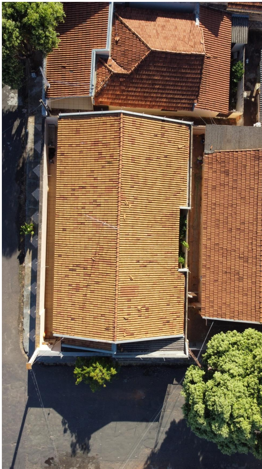
Foto 1: Visão aérea do imóvel avaliado
