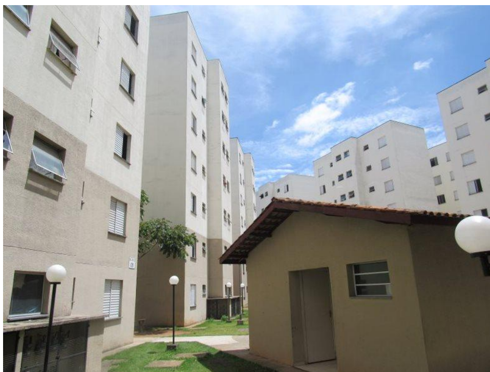
Foto 1 – Fachada do Edifício
