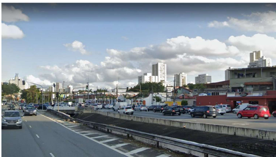
FOTO 01 – ASPECTO GERAL ESTABELECIMENTOS COMERCIAIS SP-160.
