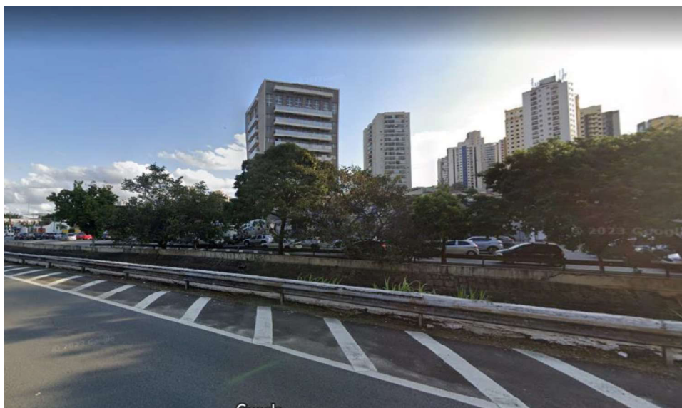
FOTO 02 – RODOVIA DOS IMIGRANTES INTERLIGANDO ZONA SUL.
