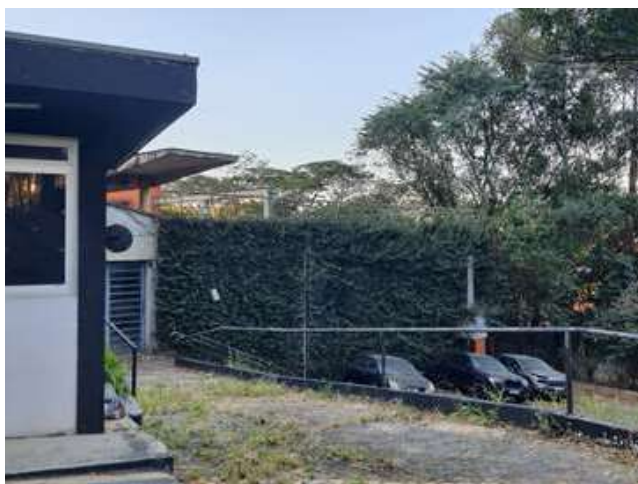
40- Área Int. final Auto Shopping, Guarita e Muro FIEO
