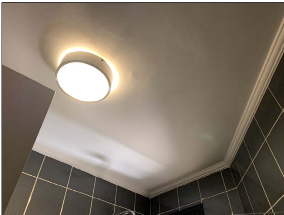
Foto 31. Detalhe do teto da suíte do dormitório 04.
