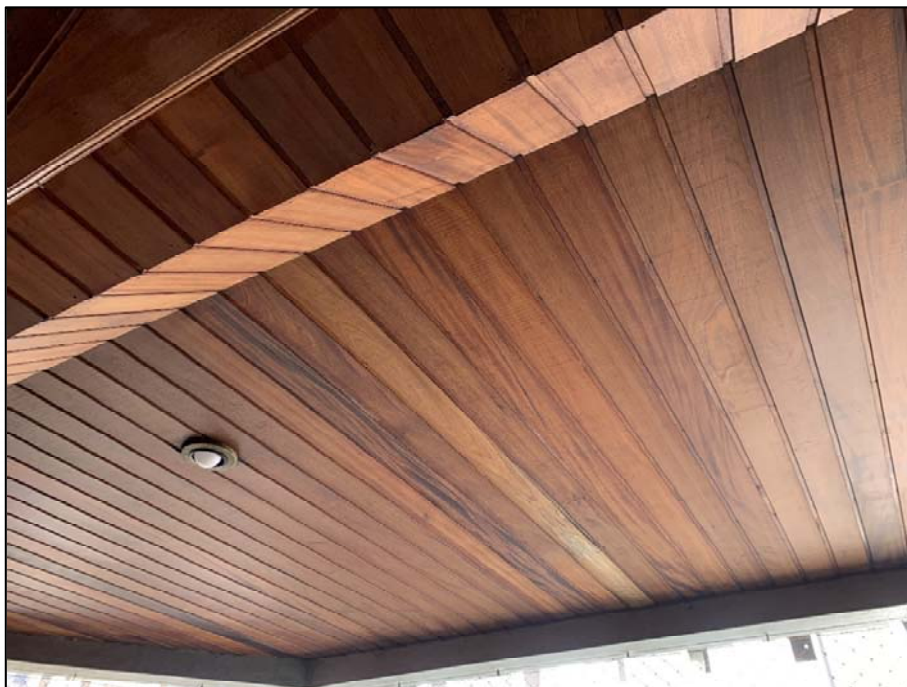
Foto 07. Detalhe do teto da varanda.
