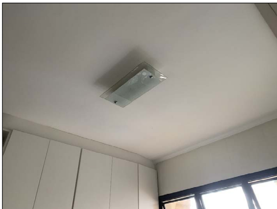
Foto 09. Detalhe do teto da cozinha.
