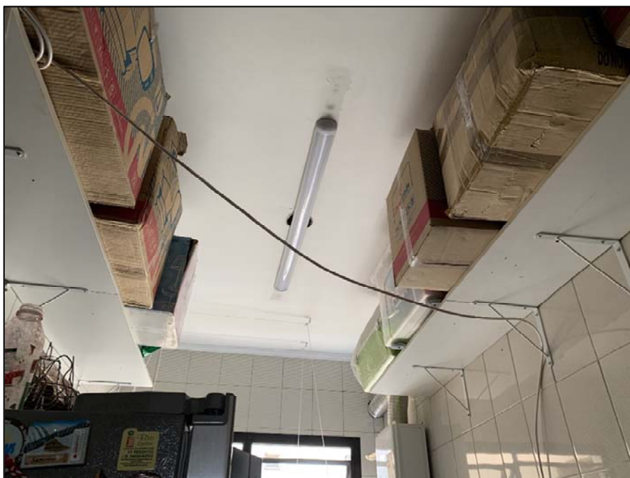
Foto 11. Detalhe do teto da área de serviço.
