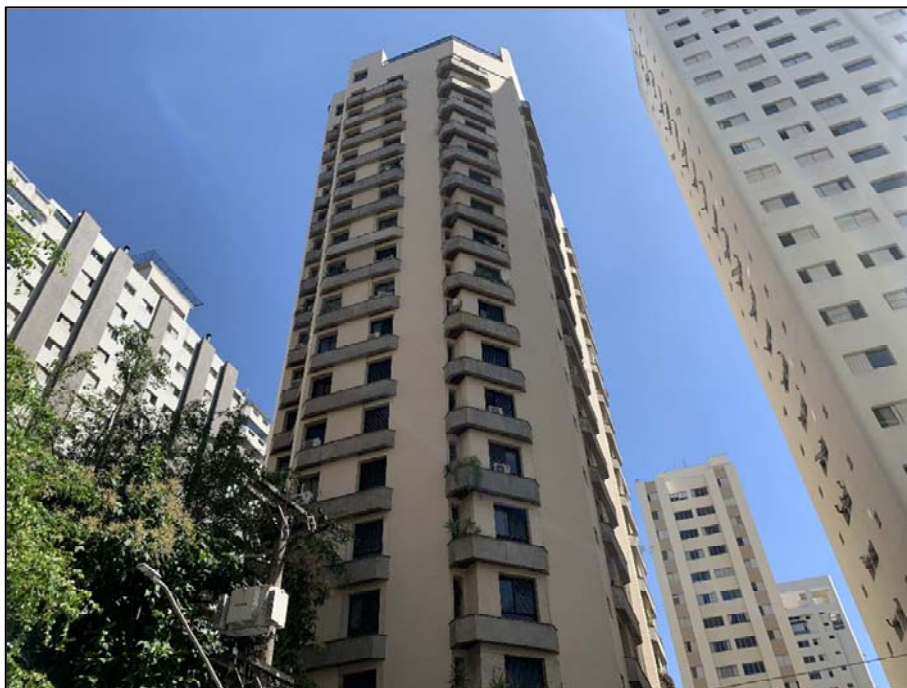
Foto 01. Fachada do imóvel avaliando.
