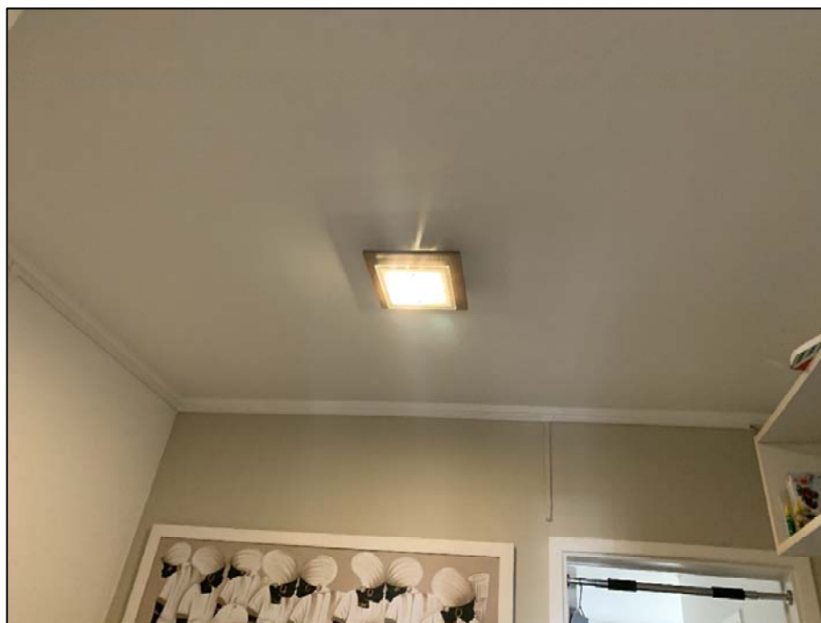
Foto 17. Detalhe do teto da área de circulação interna.
