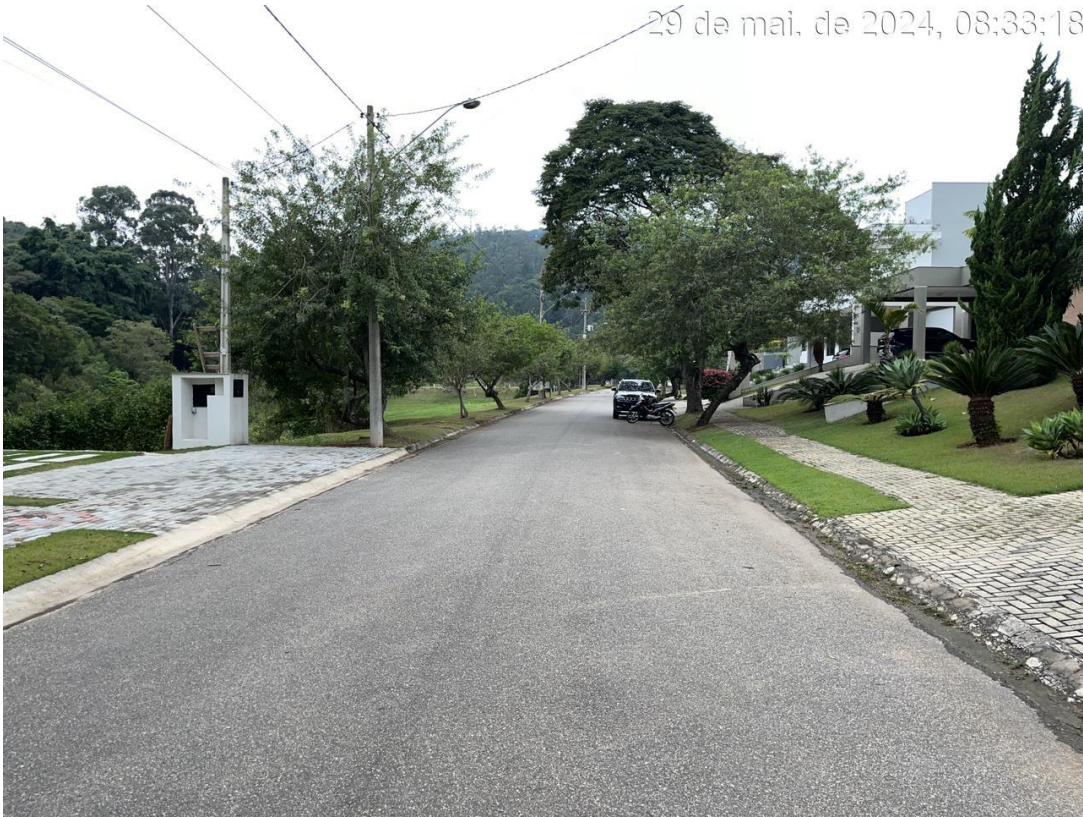
FOTO Nº 01 – VIA DE ACESSO DOS IMOVEIS AVALIANDOS (LOTES A ESQUERDA)
