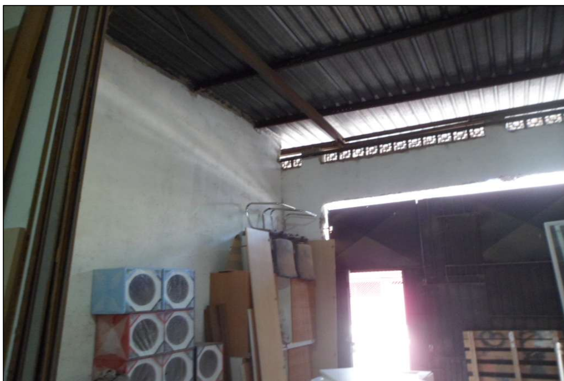
FOTO Nº 04 – Vista da frente do galpão avaliando.
