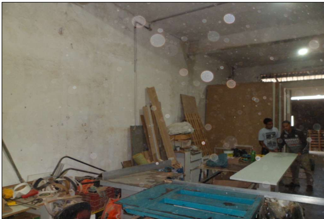
FOTO Nº 05 – Vista central do galpão avaliando.
