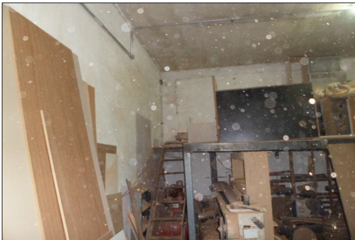
FOTO Nº 06 – Vista do fundo do galpão avaliando.
