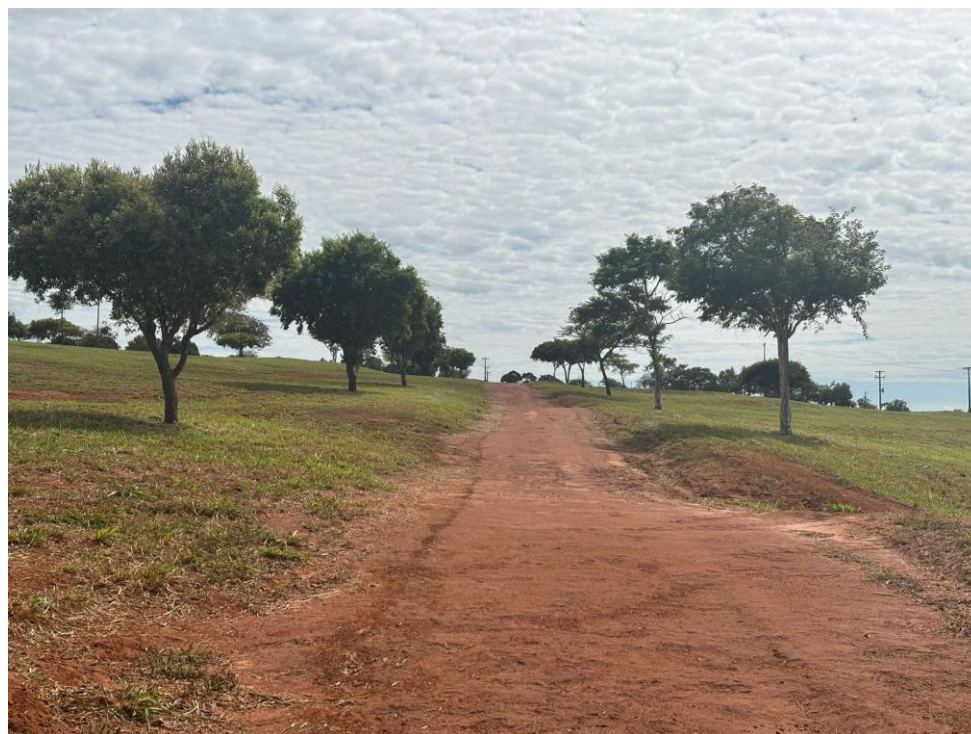
Imagem 8 – Via sem Pavimentação Fonte: Autor
