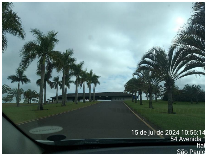
Acesso à Portaria
