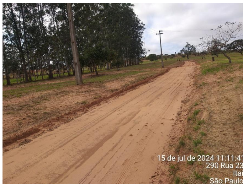
Rua 13 (Acesso ao Terreno)
