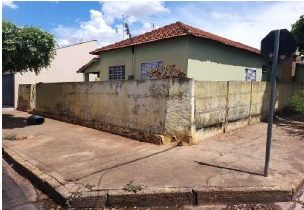
Foto da fachada
