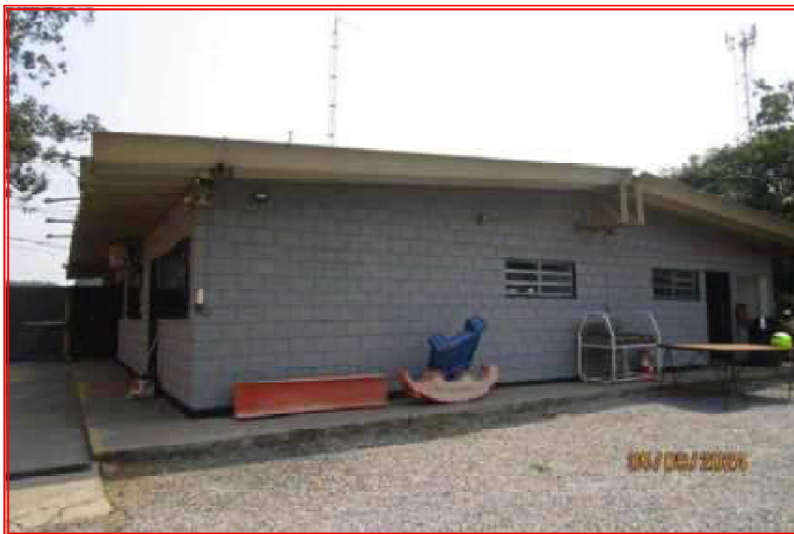
Foto nº 13: Vista da fachada da edificação.
