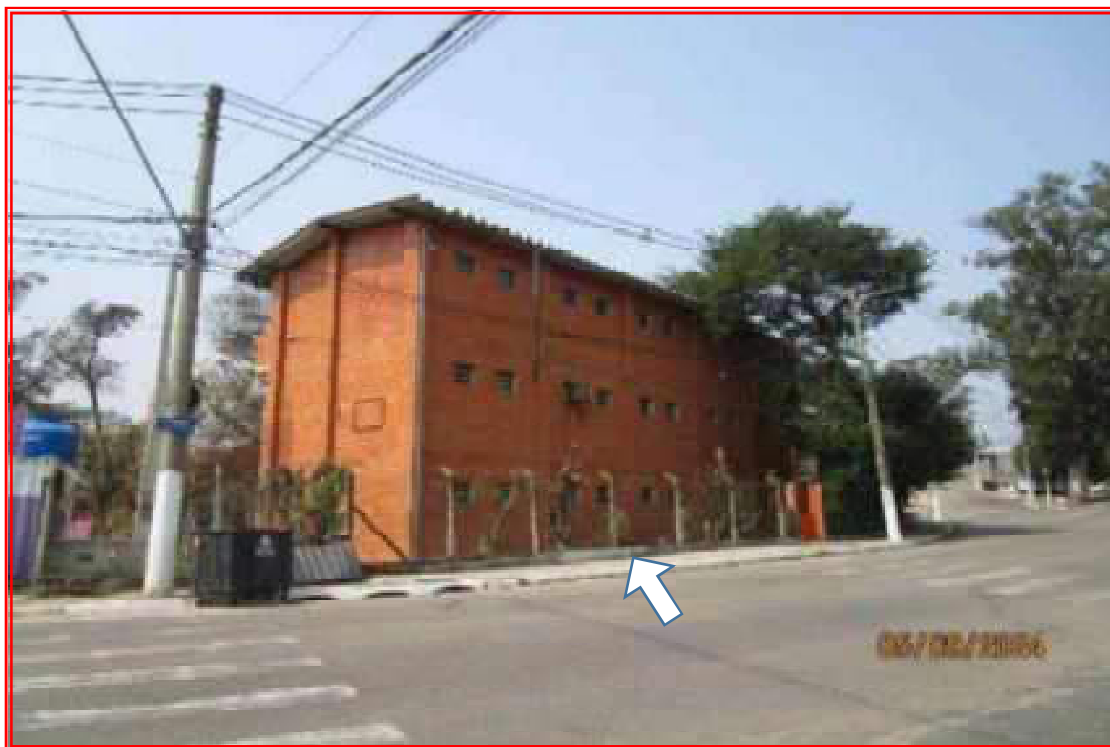
Foto n° 04: Outra vista parcial da fachada do imóvel, com detalhe para a construção composta por 3 pavimentos edificada na parte frontal da área.
