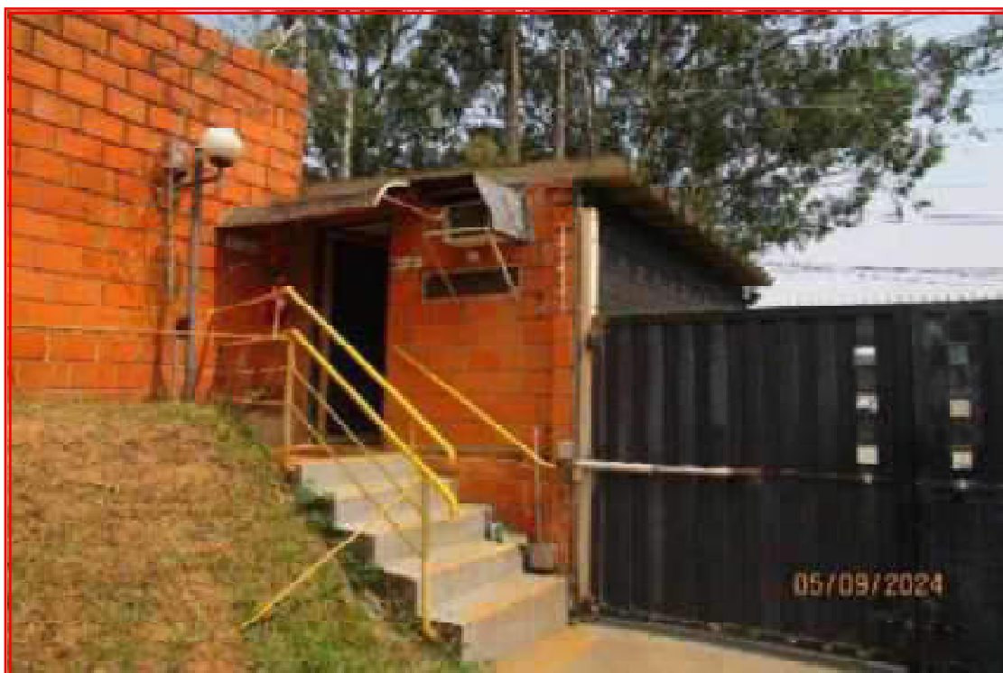
Foto n° 11: Vista geral da guarita.
