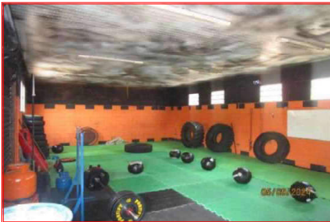
Foto n° 27: Vista do pavimento térreo.
