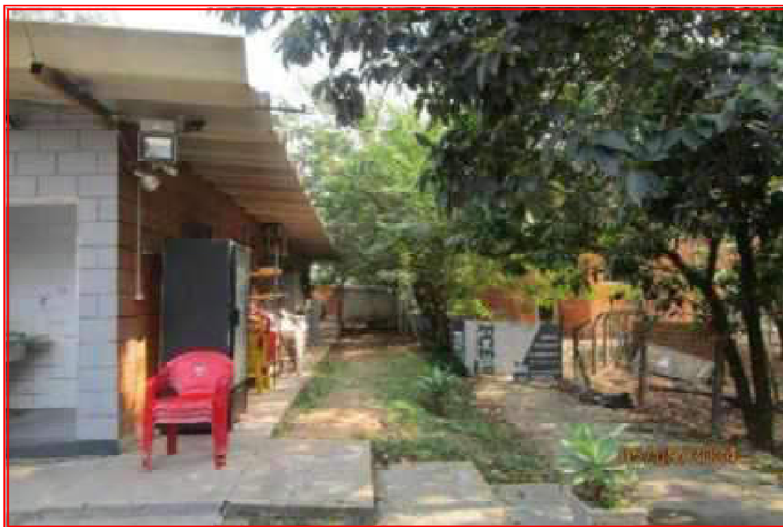
Foto n° 22: Vista parcial da lateral da edificação, acesso interno construção de 3 pavimentos e área APP.
