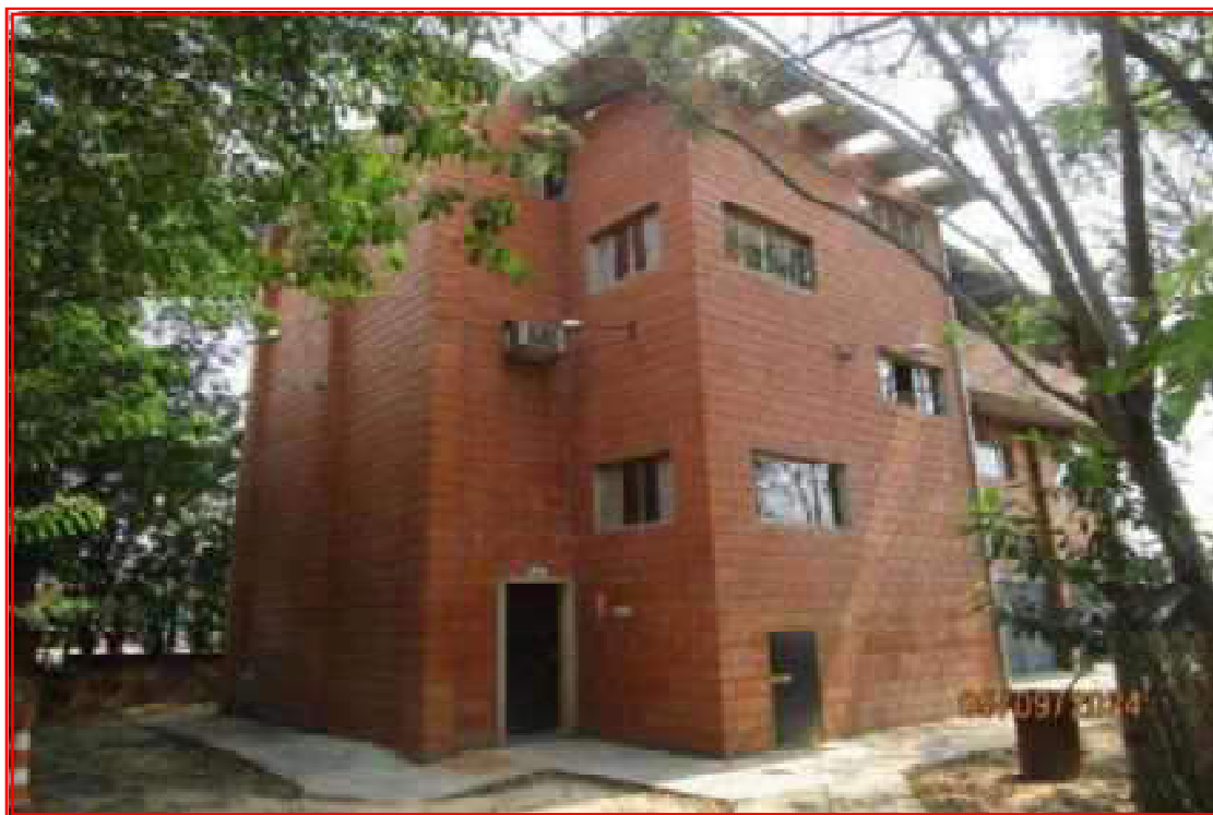
Foto nº 24: Vista geral da fachada da edificação composta por 3 pavimentos.
