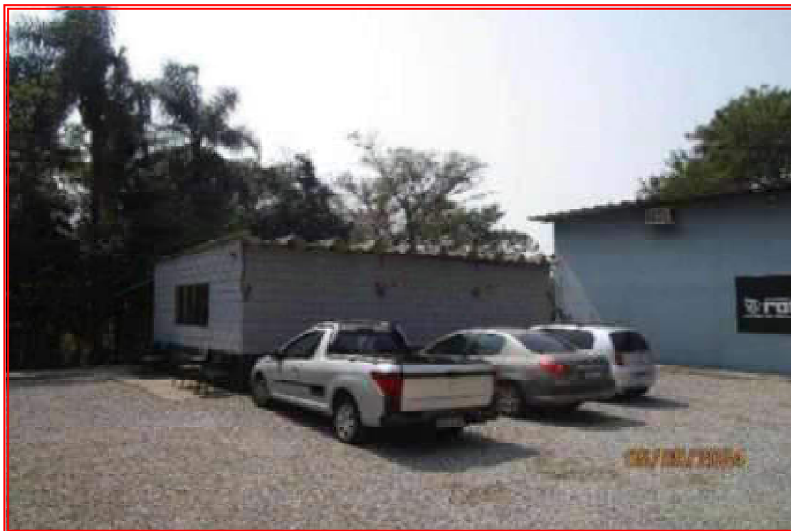
Foto n° 32: Vista geral da cobertura e bar/loja.
