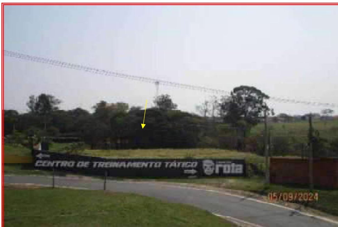
Foto n° 55: Vista parcial da área aos fundos, tomada da rodovia.
