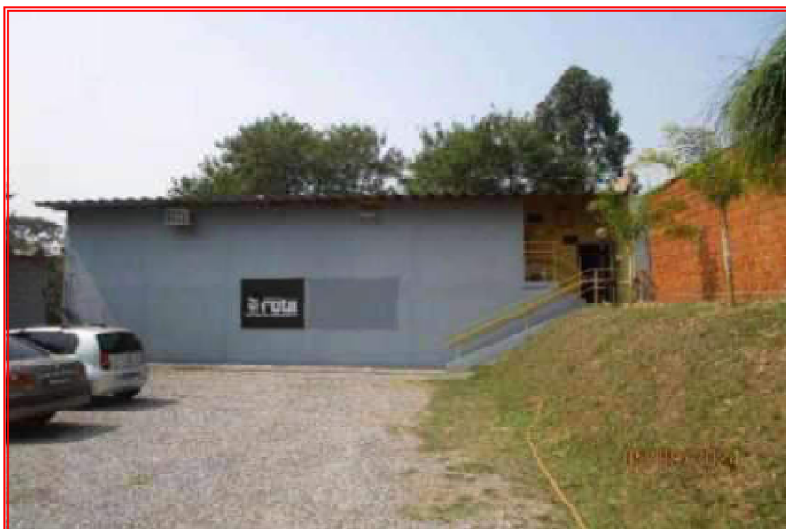
Foto n° 35: Vista geral da fachada da edificação destinada a estande de tiro e salas, composta por dois pavimentos.
