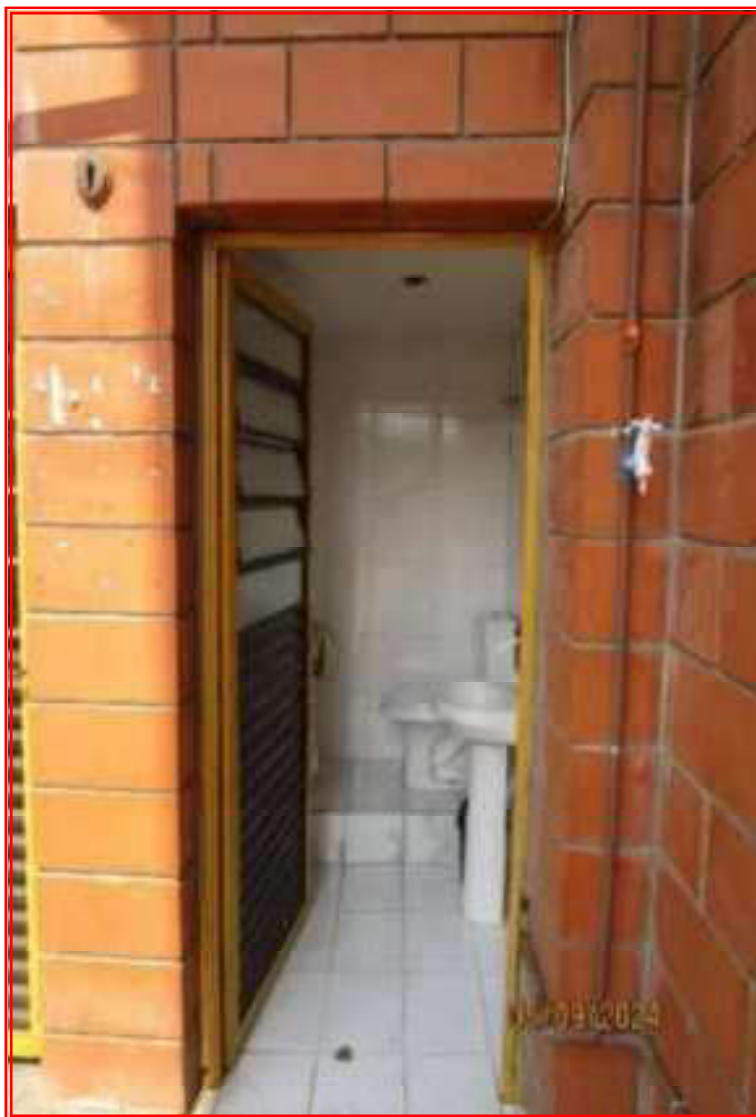
Foto nº 28: Vista geral do banheiro externo.
