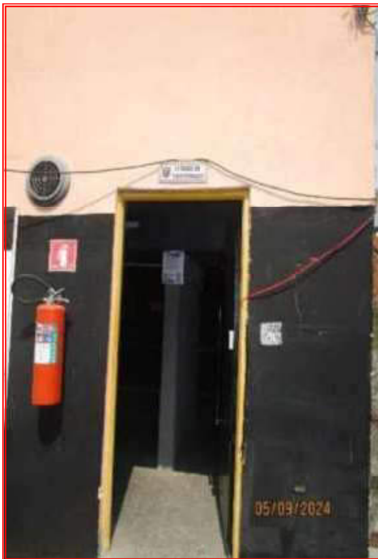
Foto nº 40: Acesso ao estande de tiro do pavimento térreo.
