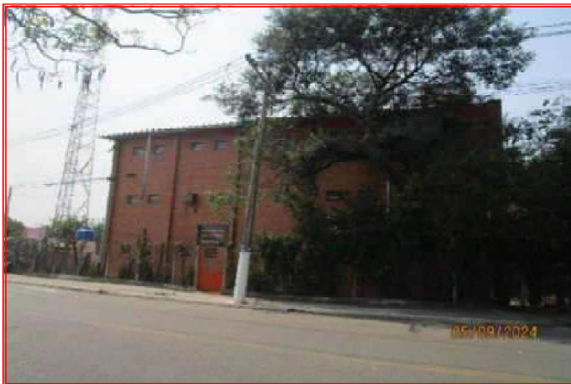
Foto n° 05: Outra vista parcial da fachada da construção composta por 3 pavimentos edificada na parte frontal da área.
