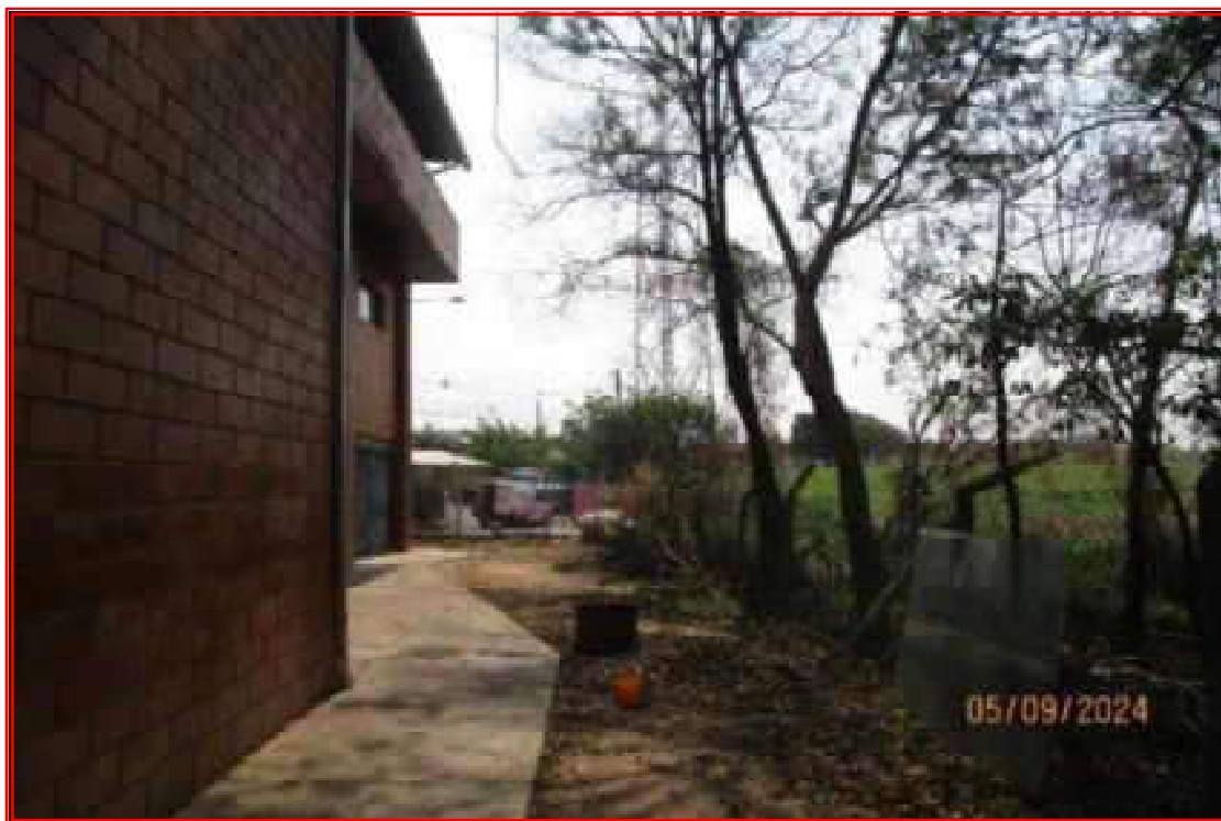
Foto n° 25: Vista da lateral da edificação.
