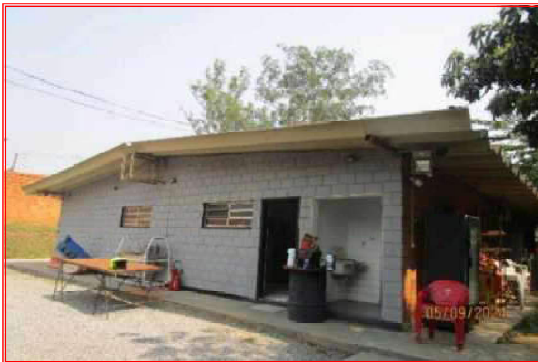
Foto n° 19: Outra vista parcial da edificação, com detalhe para o acesso à cozinha.
