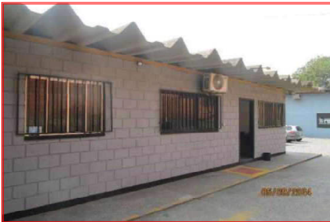
Foto n° 12: Vista parcial da fachada lateral da edificação, destinada a escritório, cozinha, vestiário e salas.
