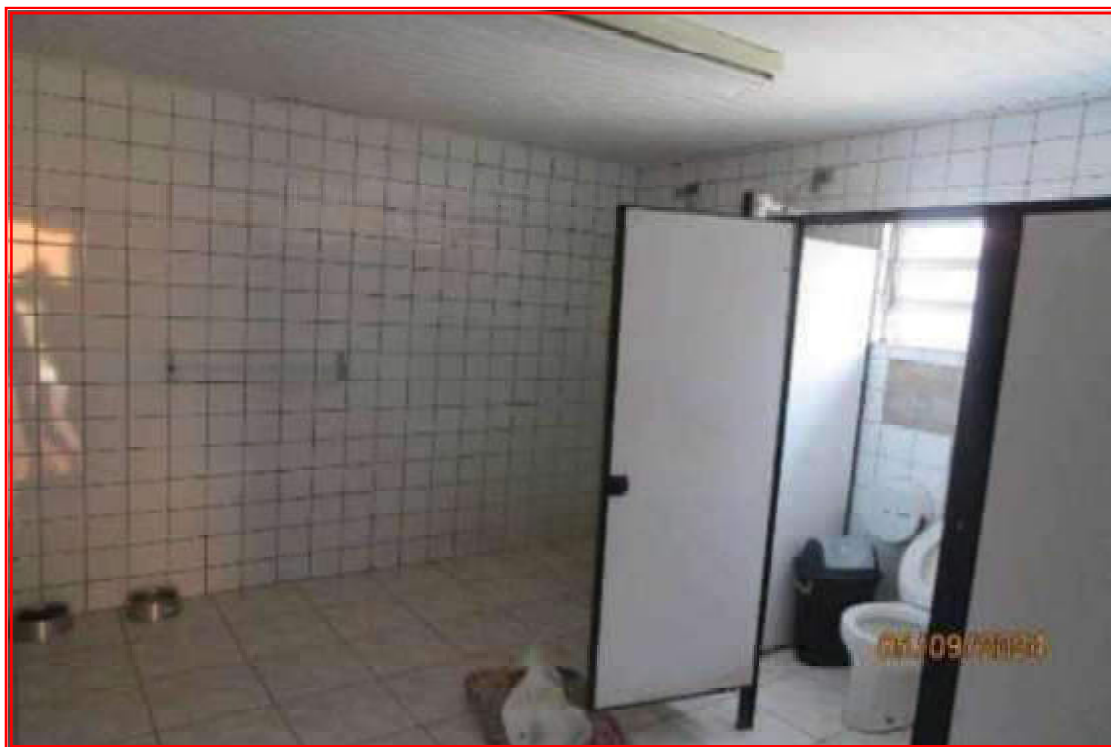
Foto n° 16: Vista parcial do vestiário.
