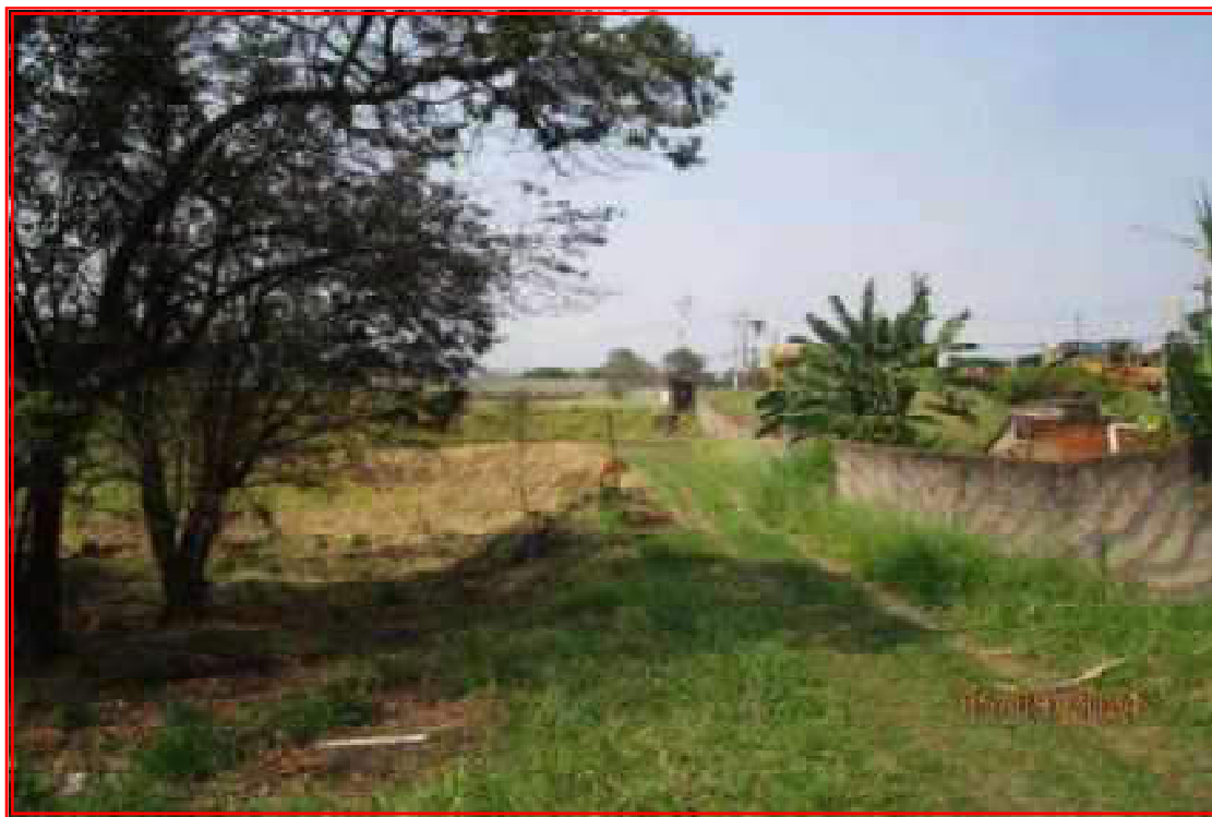
Foto n° 46: Vista parcial da área com detalhe para o muro de divisa da lateral direita.
