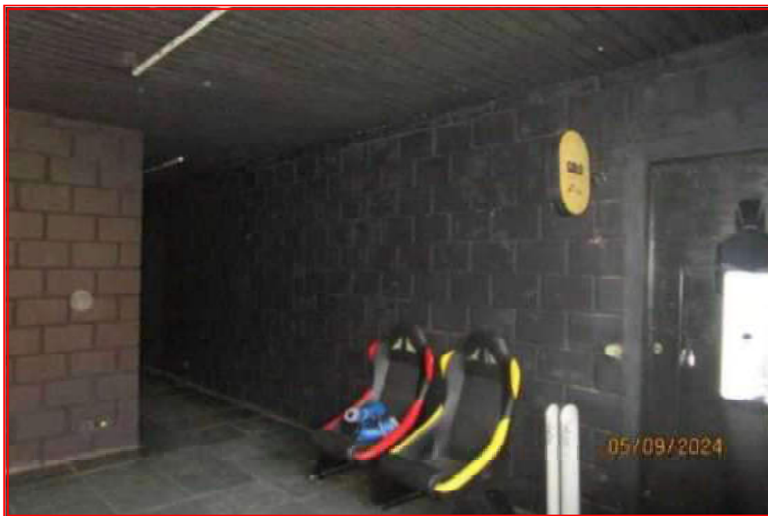
Foto n° 15: Vista parcial do acesso as salas.
