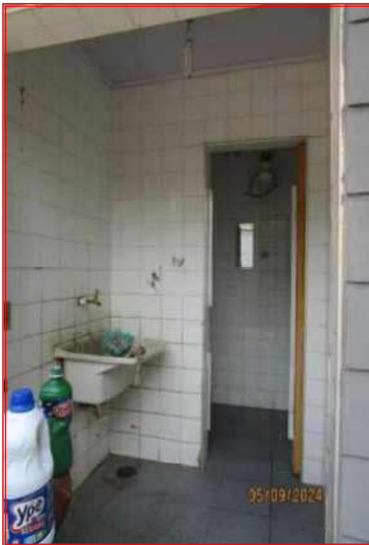
Foto nº 20: Vista parcial do banheiro.
