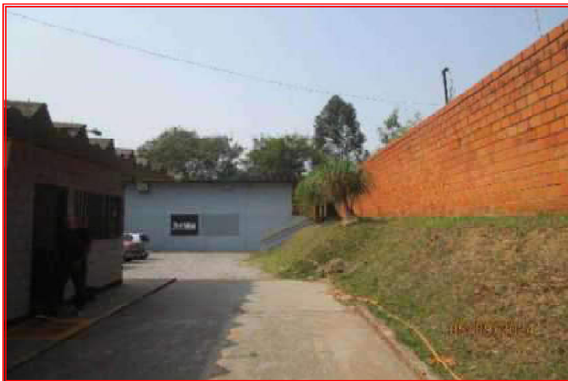
Foto n° 08: Vista parcial do imóvel, com detalhe para parte das construções e muro de divisa da lateral esquerda (de quem de frente olha o imóvel).
