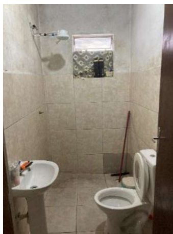
Vista do banheiro
