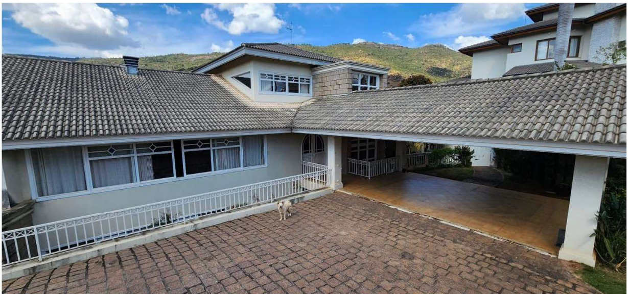
Fachada interna do imóvel.
