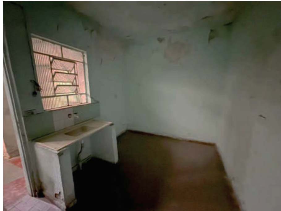
Foto 18 – Rua Estados Unidos n.º 29 – 3ª Residência – CÔMODO 1
