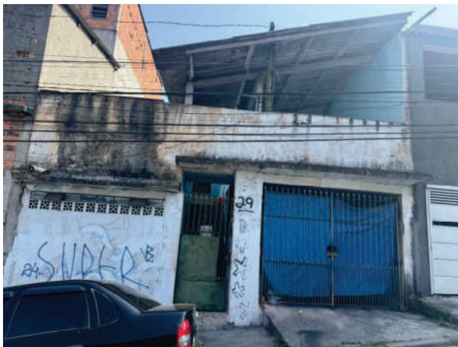
Foto 3 – Rua Estados Unidos n.º 29 – FACHADA
