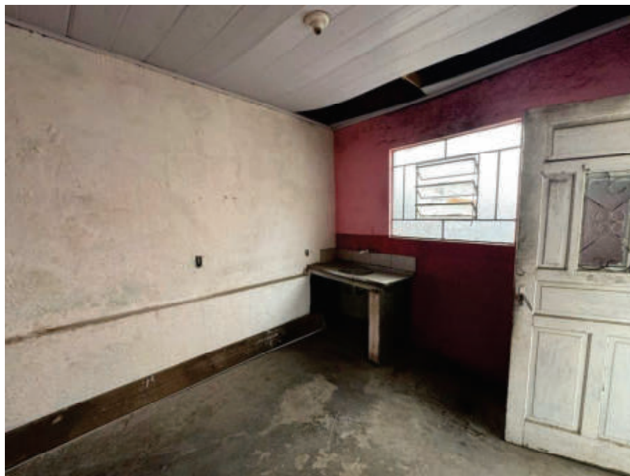
Foto 10 – Rua Estados Unidos n.º 29 – 1ª Residência – CÔMODO 1
