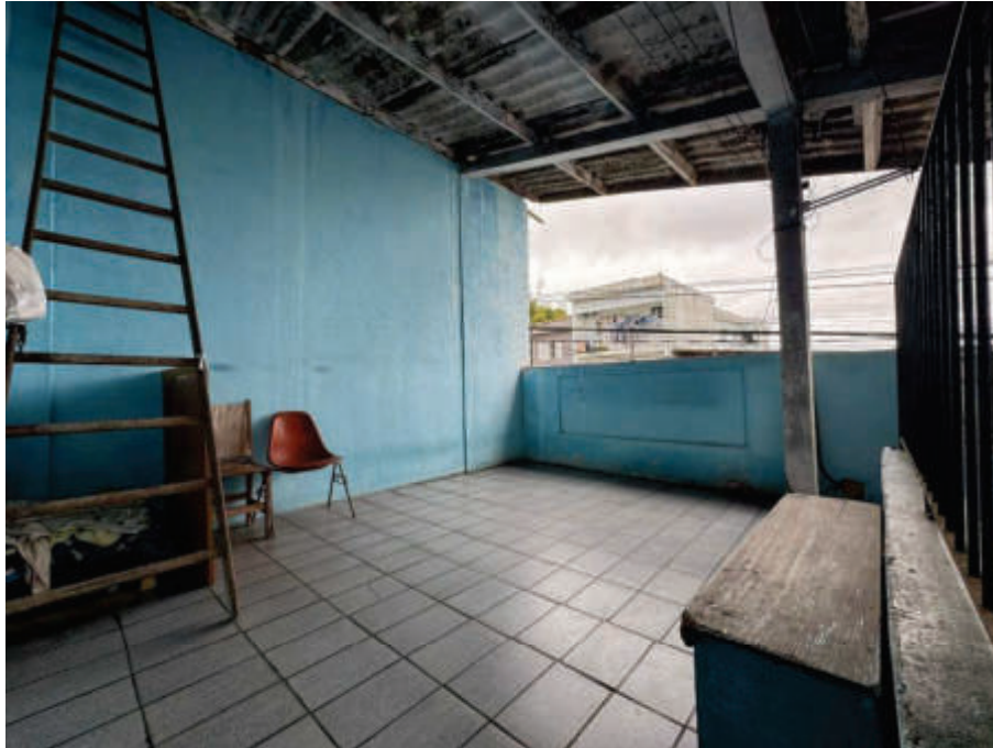
Foto 6 – Rua Estados Unidos n.º 29 – VARANDA COBERTA
