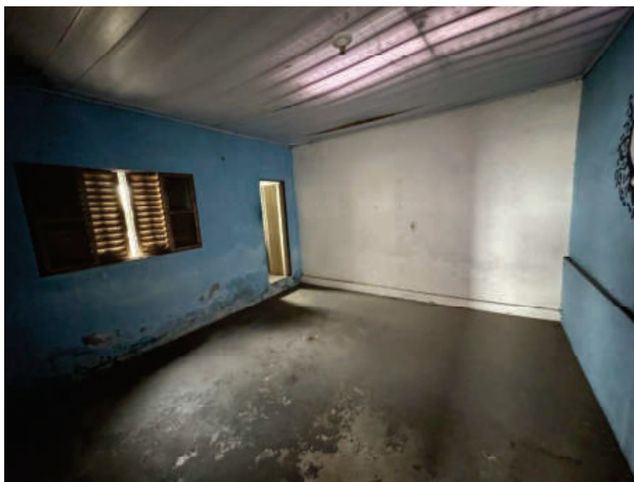
Foto 11 – Rua Estados Unidos n.º 29 – 1ª Residência – CÔMODO 2
