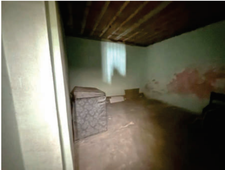
Foto 19 – Rua Estados Unidos n.º 29 – 3ª Residência – CÔMODO 2
