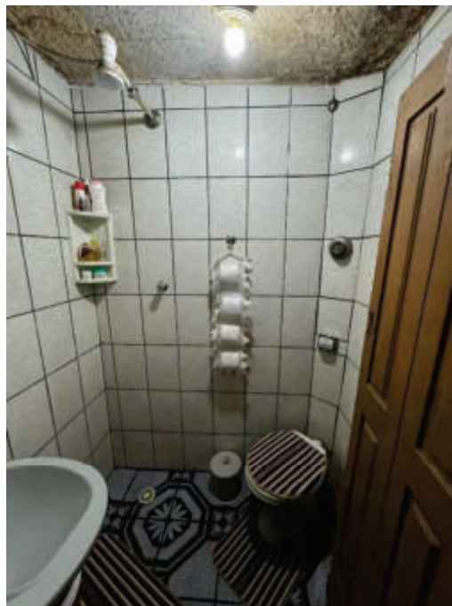
Foto 16 – Rua Estados Unidos n.º 29 – 2ª Residência – BANHEIRO
