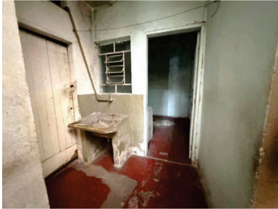
Foto 17 – Rua Estados Unidos n.º 29 – 3ª Residência – ÁREA DE SERVIÇO
