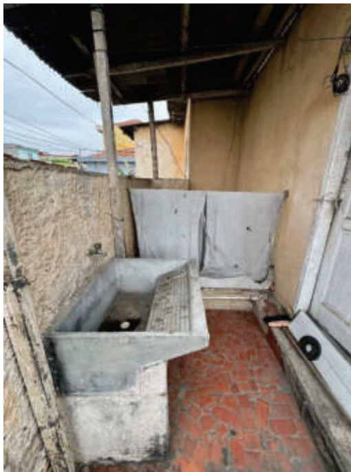
Foto 9 – Rua Estados Unidos n.º 29 – 1ª Residência – ÁREA DE SERVIÇO
