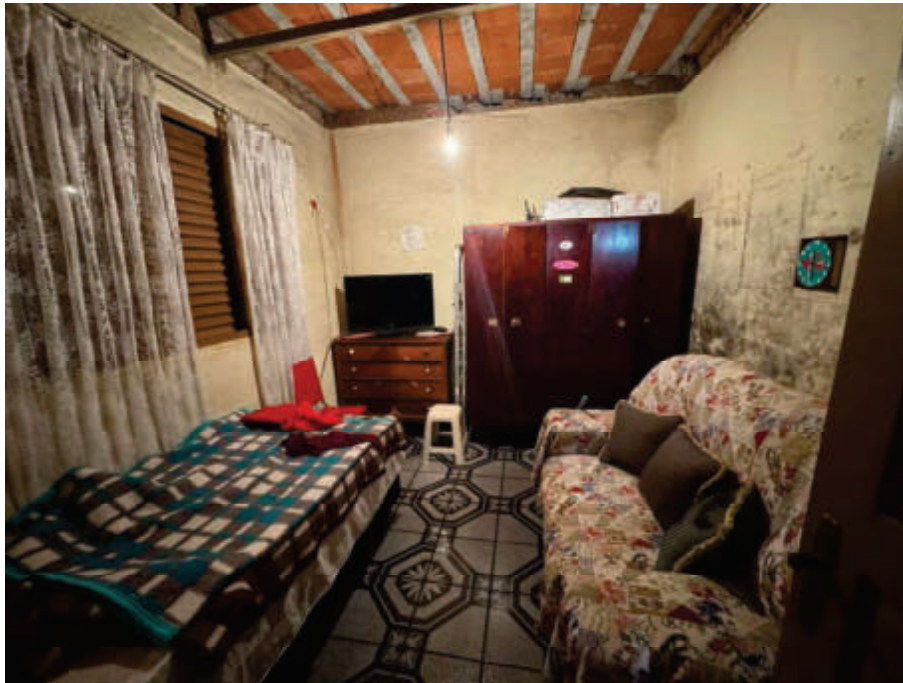
Foto 15 – Rua Estados Unidos n.º 29 – 2ª Residência – CÔMODO 2
