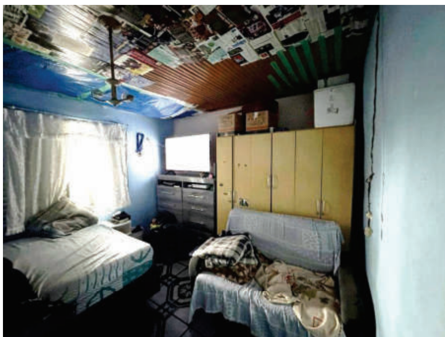
Foto 22 – Rua Estados Unidos n.º 29 – 4ª Residência – CÔMODO 2
