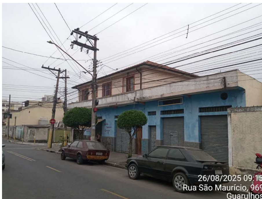
FACHADA DO IMÓVEL AVALIANDO.
