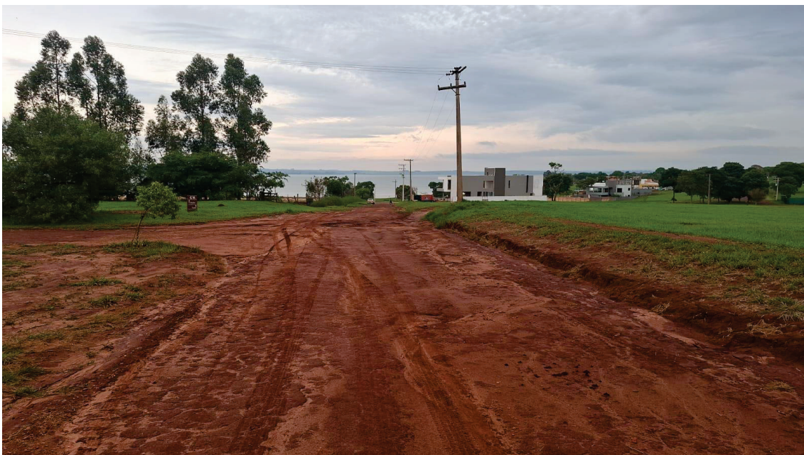
Imagem da Rua Timburi sem pavimentação, mostrando poste de iluminação.
