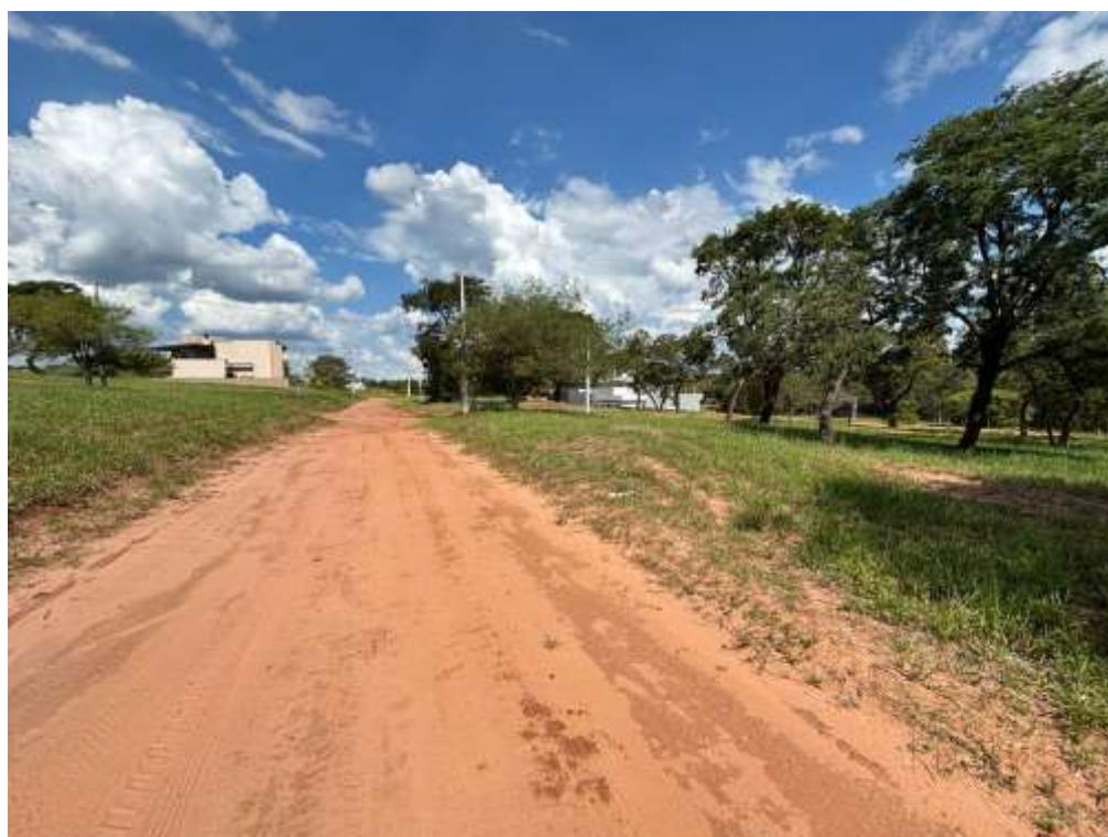
Imagem 9 – Rua 34 – sem pavimento – Outra Vista (sentido contrário) Fonte: Autor
