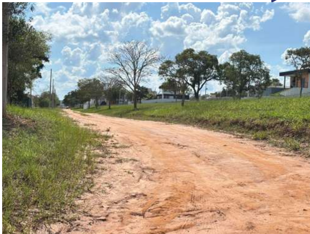
Imagem 8 – Rua 34 – sem pavimento Fonte: Autor
