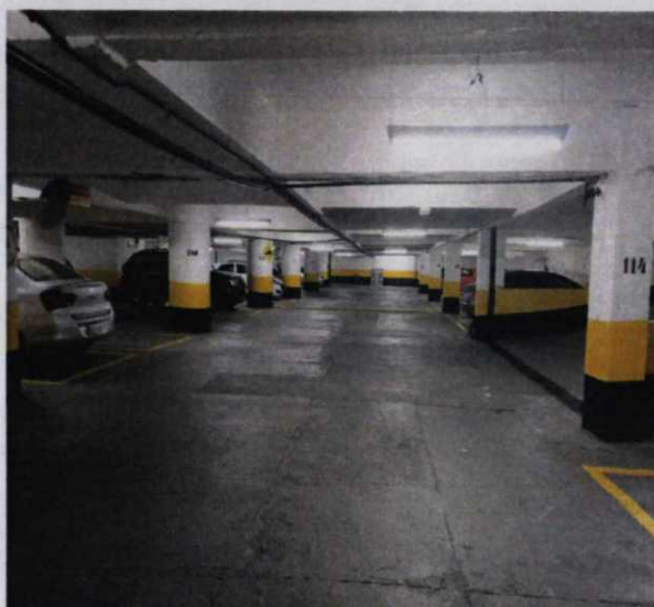
Vista do 2º subsolo - destinado a garagem
