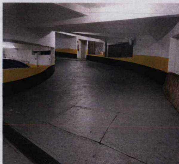
Rampa de acesso aos subsolos e térreo
