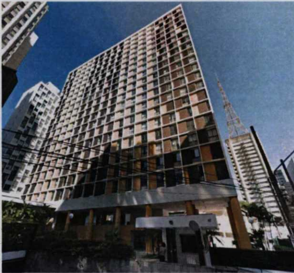
Vista da fachada lateral do edifício
