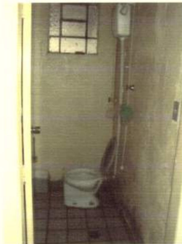
VISTA DO BANHEIRO DO PRIMEIRO DORMITÓRIO.
