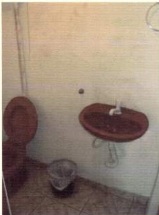
VISTA DO BANHEIRO DA SALA DE SUPERVISÃO.
