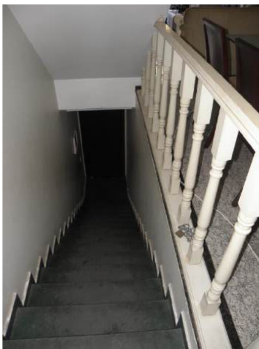
Foto: escada de acesso ao 1o pavimento.
