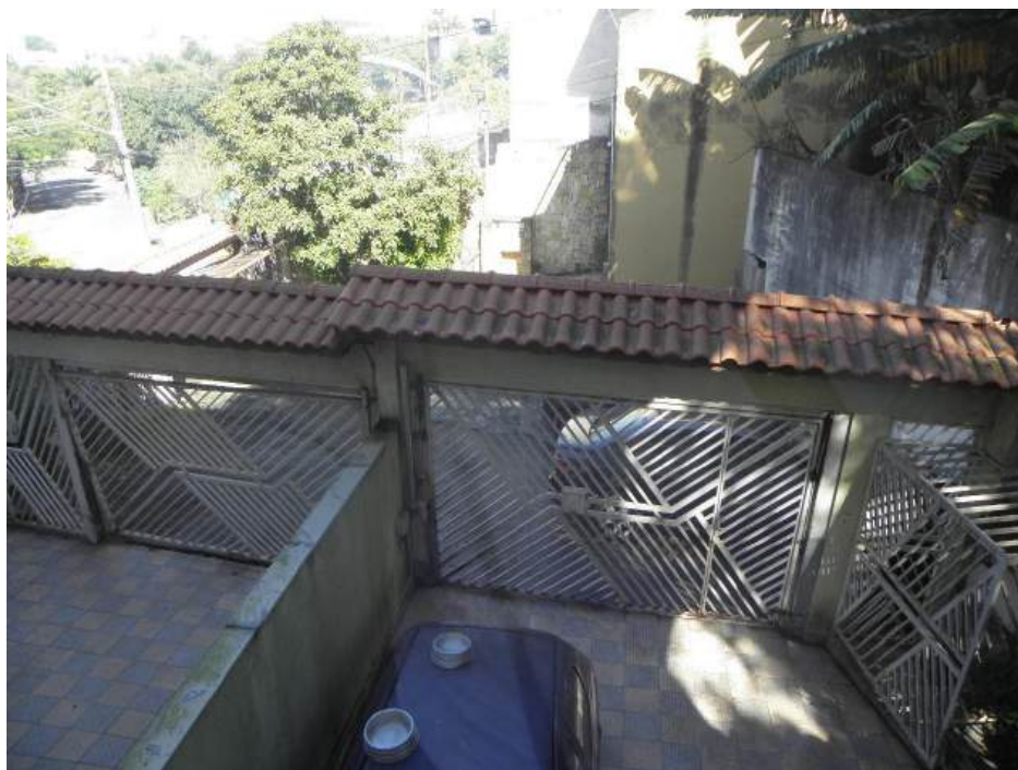
Foto: visão do portão de entrada.
