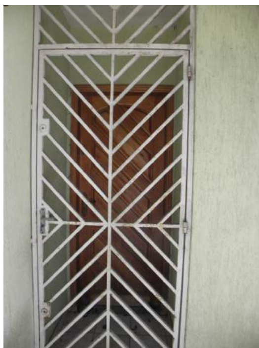
Foto: acesso à porta de entrada social.
