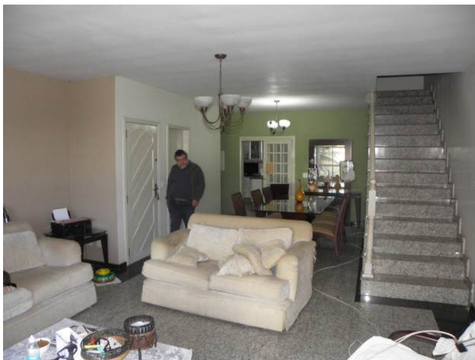
Foto: sala com escada de acesso ao 1o pavimento.
