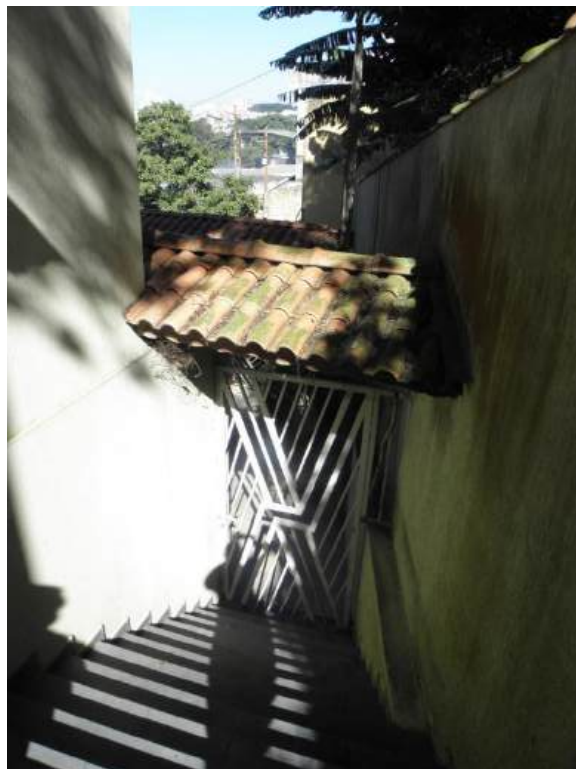
Foto: escada lateral de acesso.
