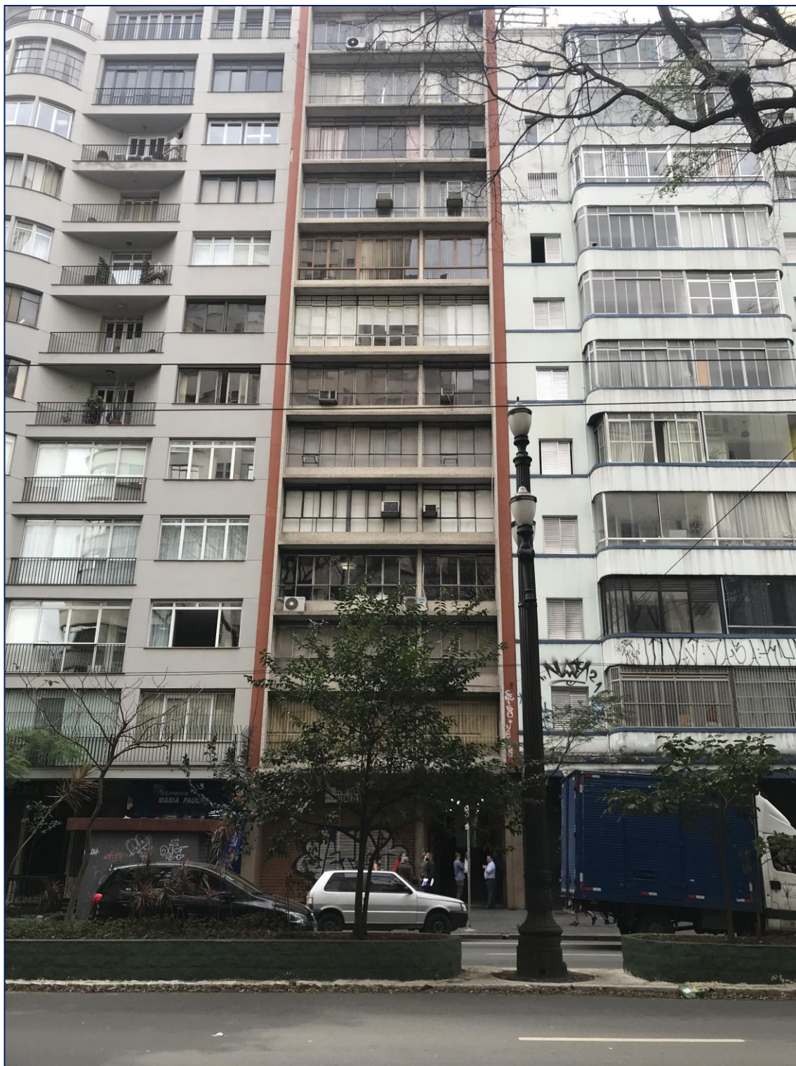
FOTO 03: VISTA DA FACHADA DO EDIFÍCIO CAVARÚ.
