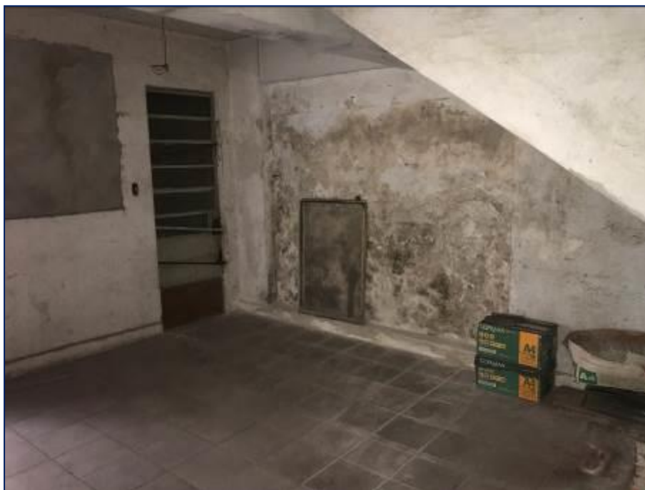
FOTO 22: VISTA DDOS FUNDOS DO SALÃO DO 2º SUBSOLO.
