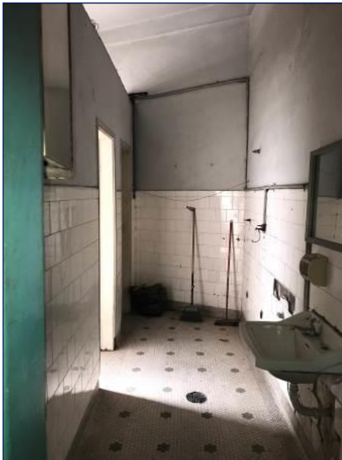
FOTO 09: VISTA DO BANHEIRO
