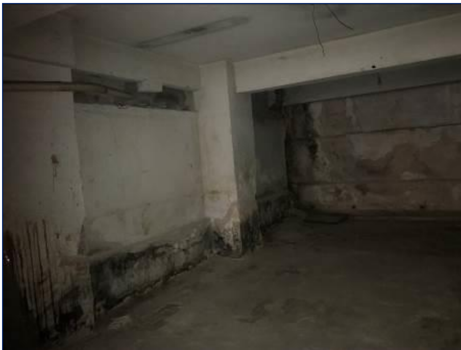
FOTO 18: VISTA DA SALA DO 2º SUBSOLO.
