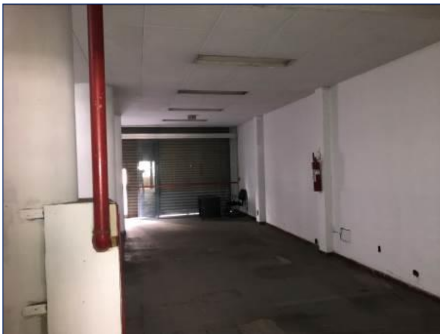
FOTO 06: VISTA INTERNA DA LOJA (TÉRREO).
