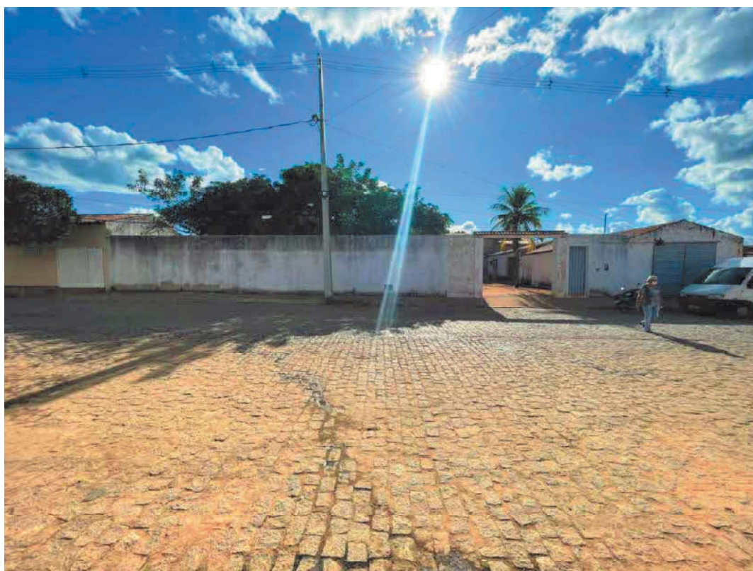
Figura 2: Vista externa do imóvel.
